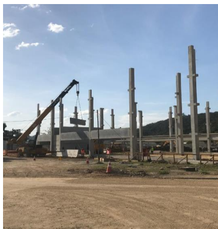
Figura 10: Obra em andamento – Prédio Principal Setor 1
