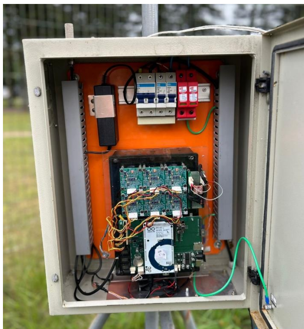
Figura 5 - Equipamento de baixo custo CLEAN instalado na Universidade Federal de Santa Catarina
