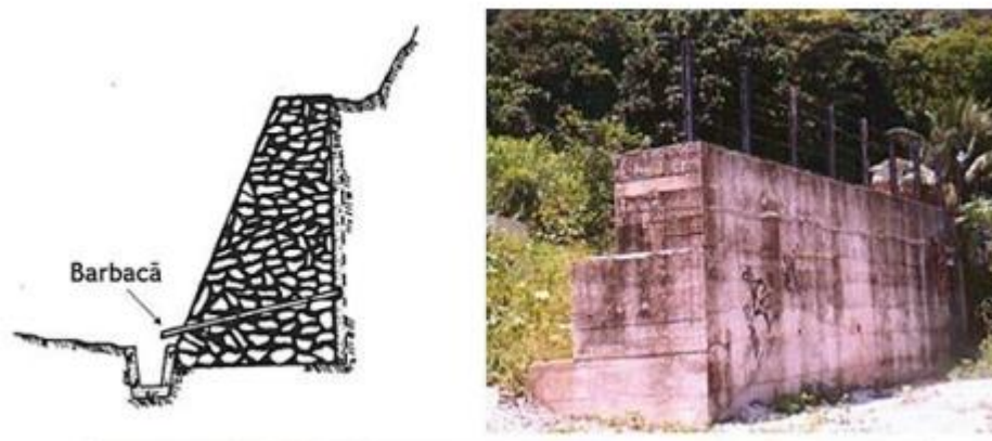
Figura 6: Muros de concreto ciclópico.
