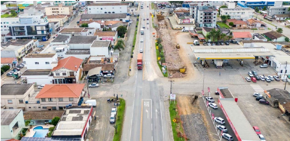
Figura 17: Imagem aérea do local da obra.
