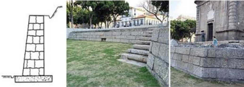
Figura 5: Muros de alvenaria de pedra.
