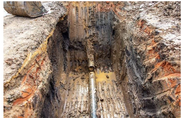
Figura 19: Escavação na marginal da rodovia.
