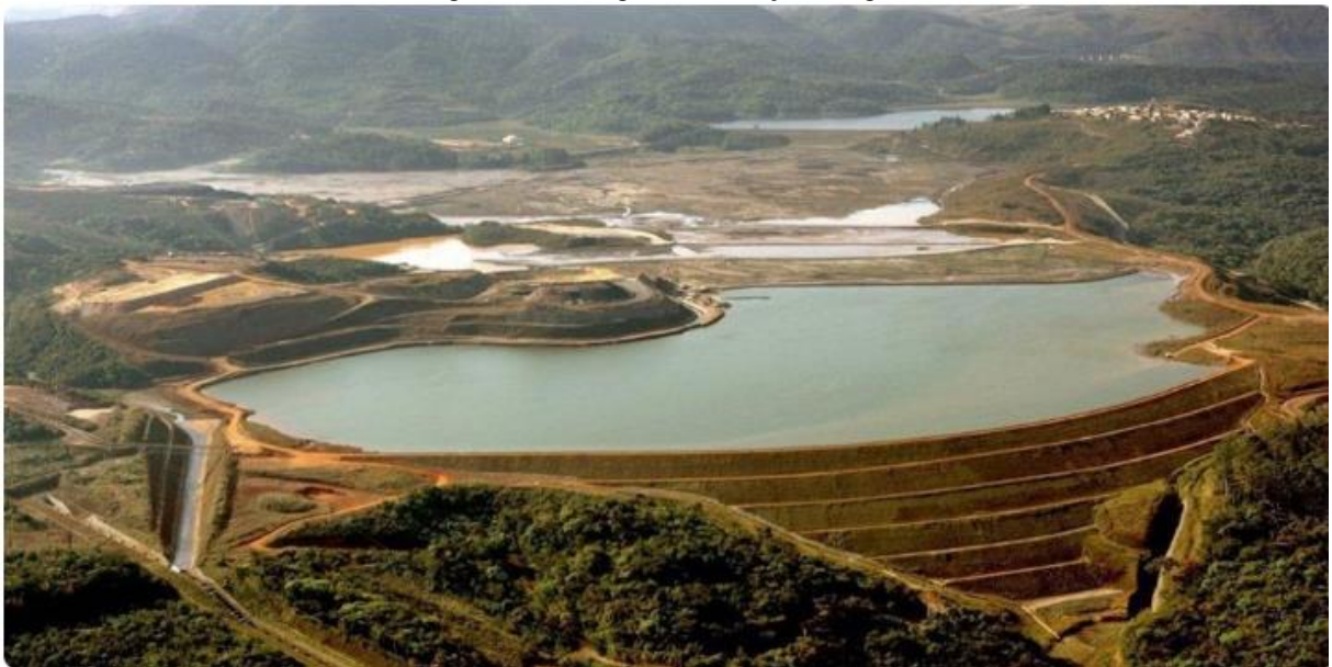
Figura 2 – Barragem de retenção de água
