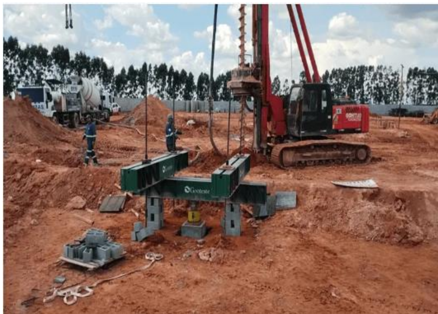
Figura 5 - Execução da Prova de Carga estática
