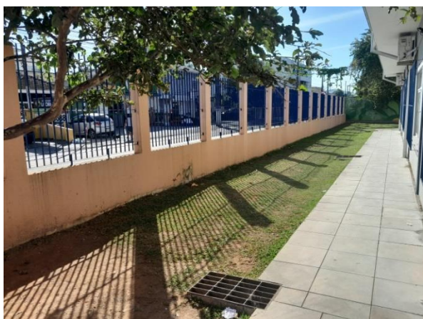
Figura 29 – Foto (faixa de terra 5) entre o auditório e a rua externa
