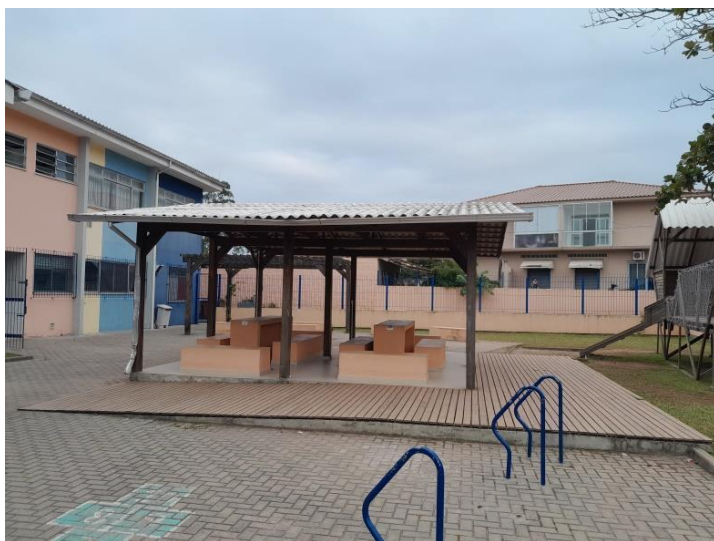
Figura 43 - Captação de água de chuva do telhado de área de convivência para experiências junto aos estudantes
