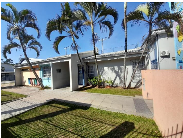
Figura 9 – Edificação das salas de artes
