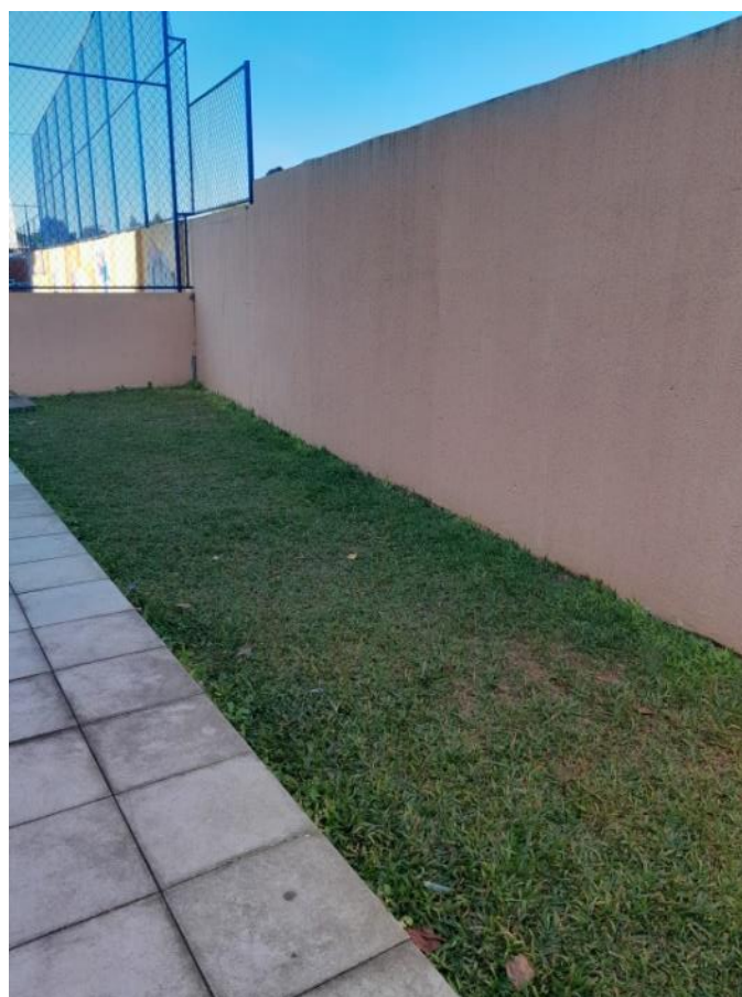
Figura 26 – Foto (faixa de terra 3) da área de plantação de PANCs atrás da sala 6
