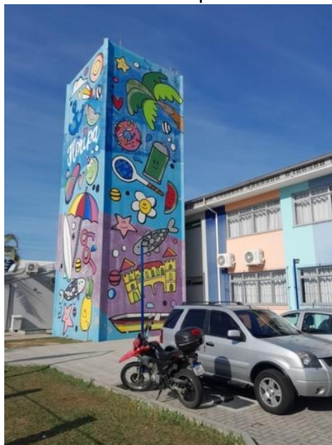
Figura 42 – Caixa da água com fornecimento pela CASAN
