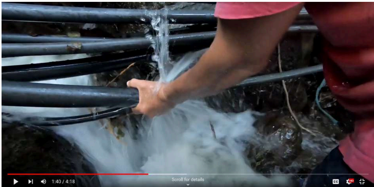
Figura 52: manutenção das mangueiras de captação de água da cachoeira. Fonte: autor.
