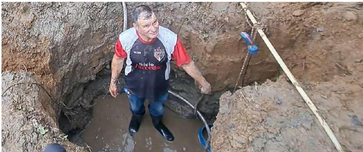
Figura 15: Miro dentro do buraco cavado para a instalação do biodigestor em setembro de 2023. A água começou a aflorar a 1,3m de profundidade. Fonte: autor.
