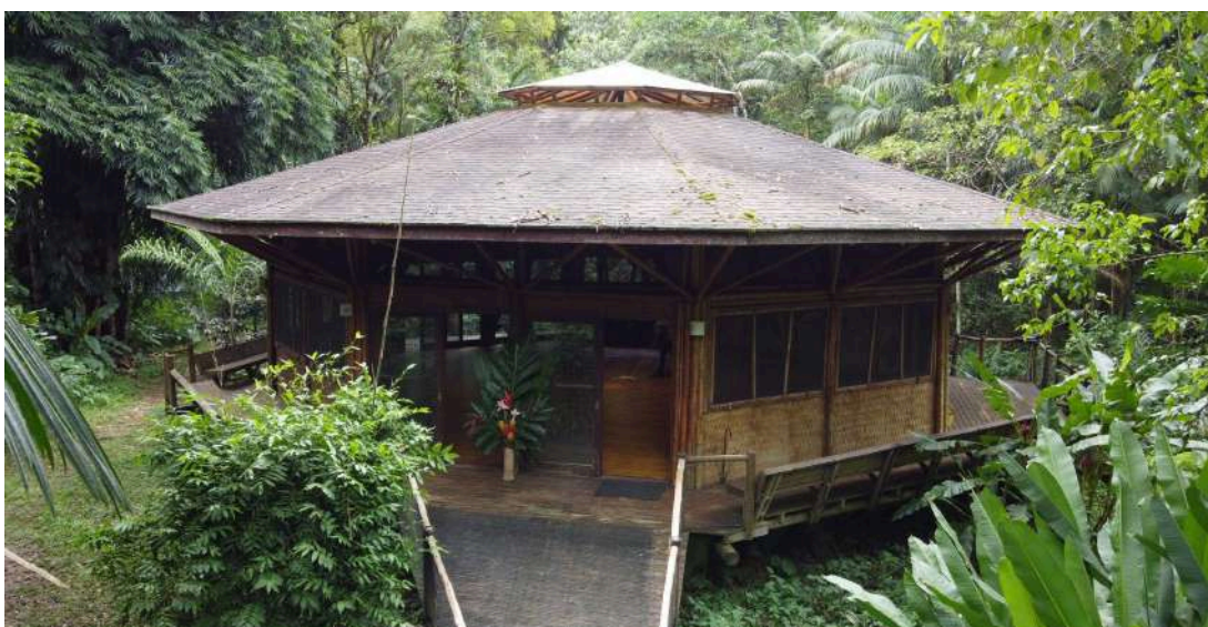
Figura 34: referência brasileira encontrada no Banana Bamboo Eco Lodge, no município de Ubatuba, em São Paulo. Uma edificação palafitada, bioconstruída com eucaliptos e bambus. Fonte: autor.
