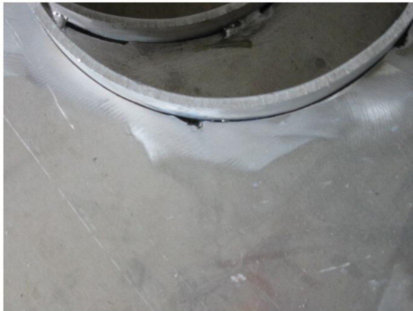
Figura 15 - Entalhe em região a ser soldada
