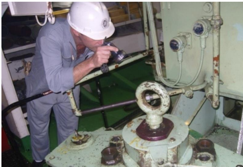
Figura 18 - Inspetor na Máquina do Leme
