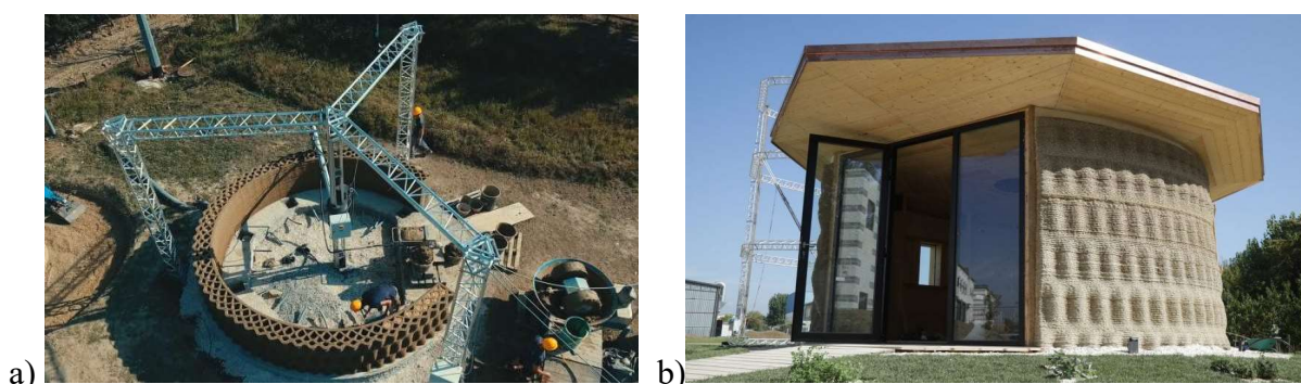
Figura 1: a) Casa Gaia sendo construída e b) Casa Gaia finalizada. Fonte: [21].
