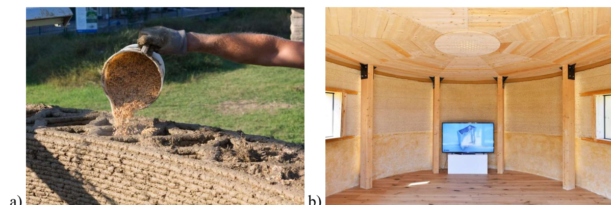
Figura 2: a) preenchimento das paredes com resíduos e b) Revestimento interno. Fonte: [21].
