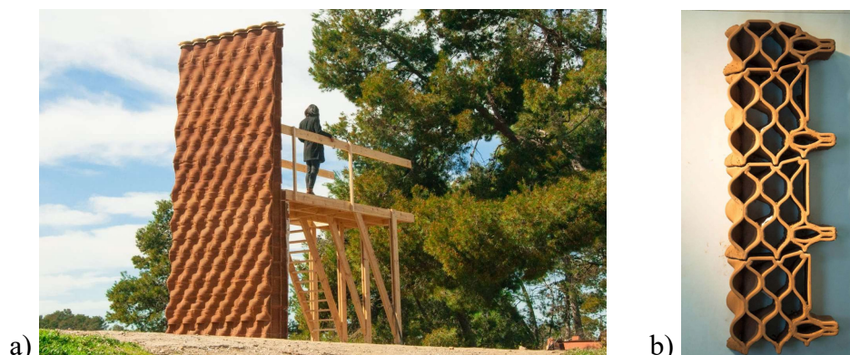
Figura 5: a) Parede construída pelo projeto Digital adobe e b) módulos da parede. Fonte: [25]
