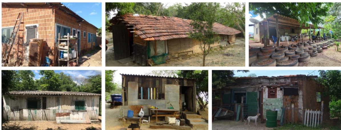
Figura 5: Residências dos ribeirinhos da APA Baía Negra. Fonte: elaborado pelos autores.
