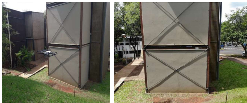
Figura 4: Drone Mavic Air 2 capturando as fachadas da Unidade 001 Unit (Esquerda), Foto capturada (Direita). Fonte: Elaborado pelos Autores (2022)
