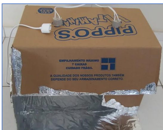
Figura 2: Instalação dos fios elétricos nos bocais. Fonte: elaborado pelos autores.
