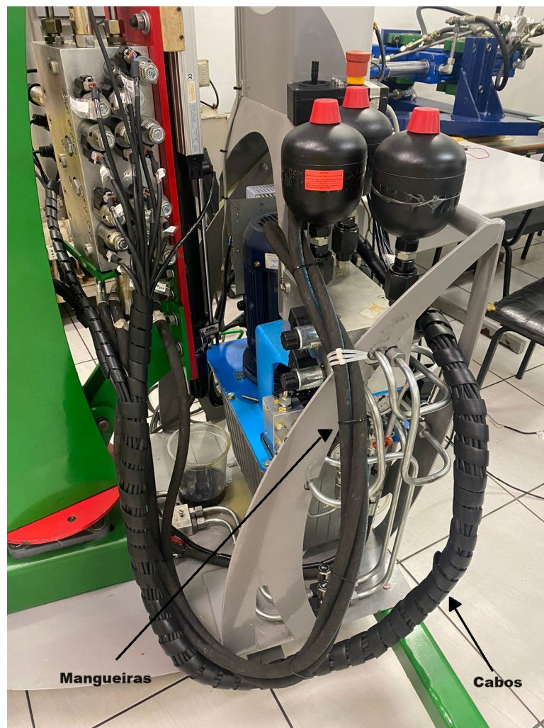
Figura 28 – Cabos reposicionados junto às mangueiras hidráulicas.
