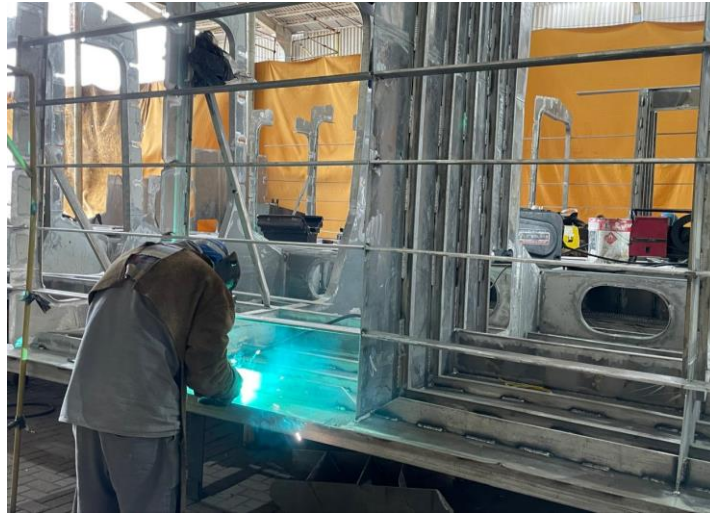
Figura 26 - Soldagem da estrutura do casco
