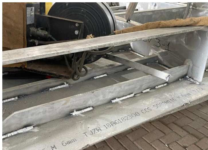
Figura 27 - Solda realizada em uma estrutura de alumínio
