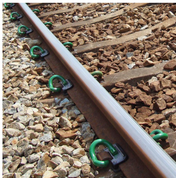
Figura 1: Imagem de grampo aplicado na linha férrea.
