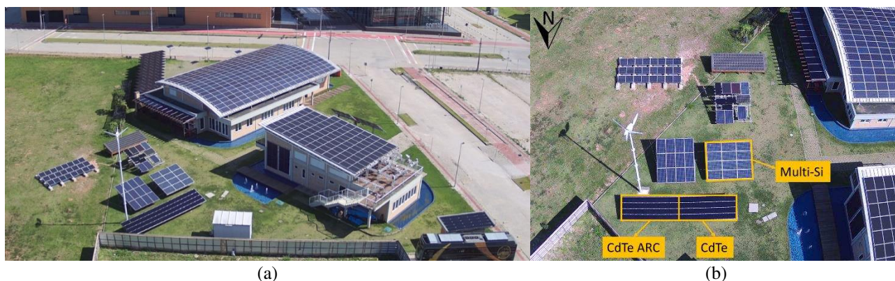
Figura 1 - Imagem aérea do laboratório Fotovoltaica-UFSC em Florianópolis-SC (27,4°S; 48,4°O) (a), e vista dos sistemas em solo do laboratório, destacando os três sistemas analisados neste estudo (b).
