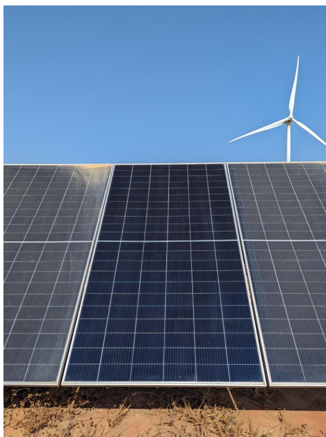
Figura 5 – Imagem ilustrativa de módulos FV para comparação entre módulos limpos e sujos.
