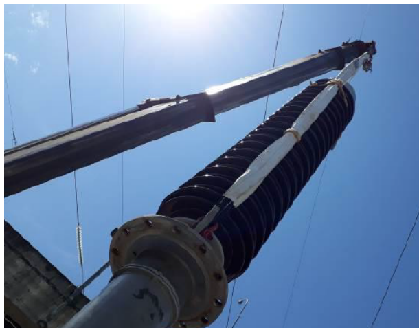
Figura 41 – Montagem da bucha reserva (caso 1).
