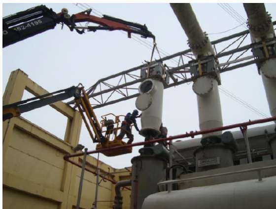
Figura 48 – Posicionamento da bucha reserva para realização de ensaios (caso 2).
