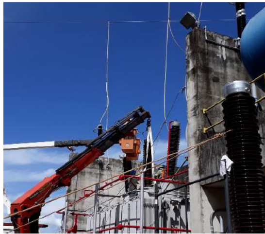
Figura 40 – Bucha original retirada (caso 1).
