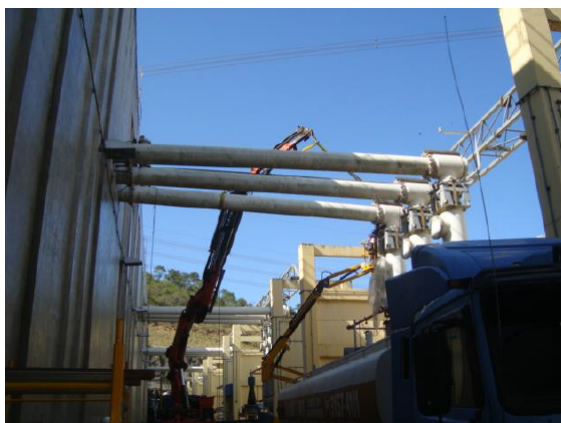
Figura 46 – Desmontagem da SIG (caso 2).
