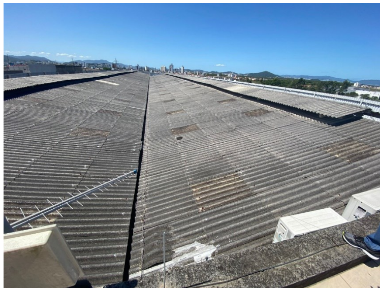
Figura 11 – Material e estado geral do telhado
