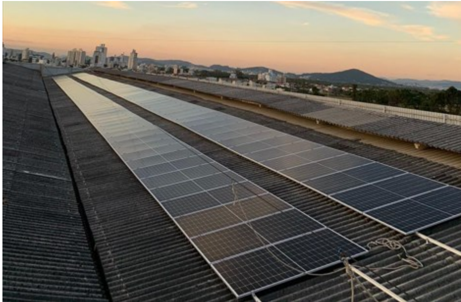
Figura 21 – Instalação dos Módulos Fotovoltaicos
