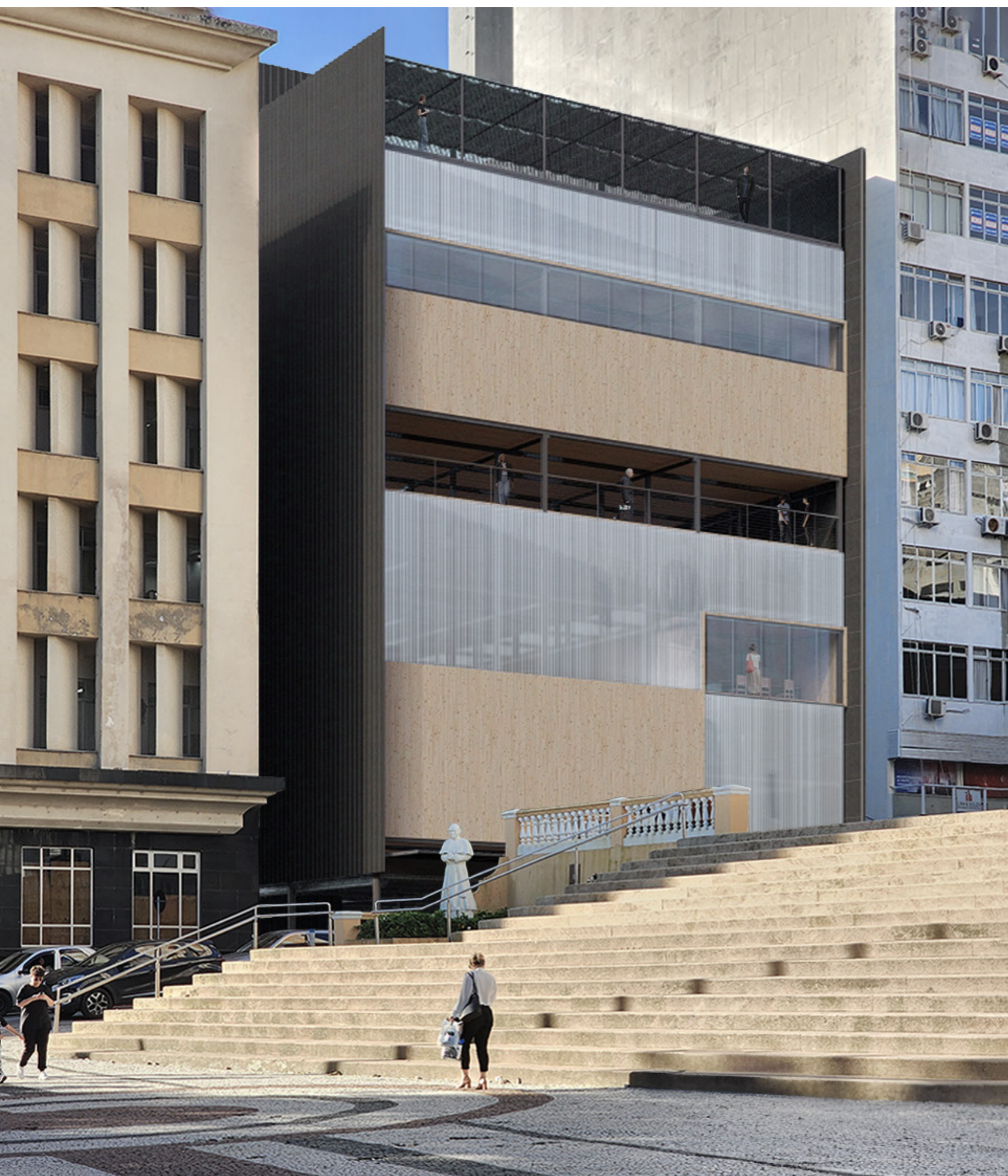
fachada rua arcepreste paiva
