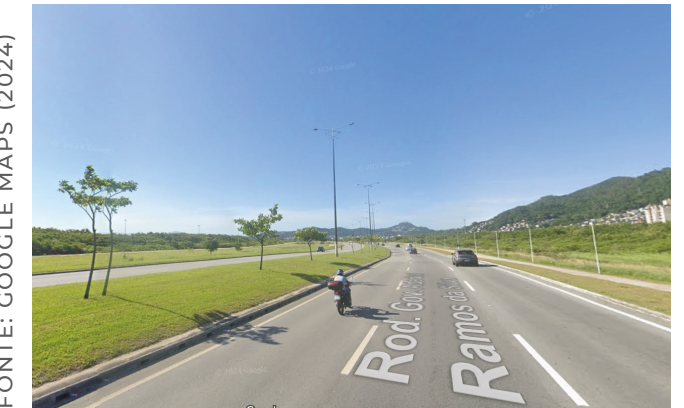
imagem 10 Situação atual da Rodovia Governador Aderbal Ramos da Silva, no bairro Costeira do Pirajubaé
