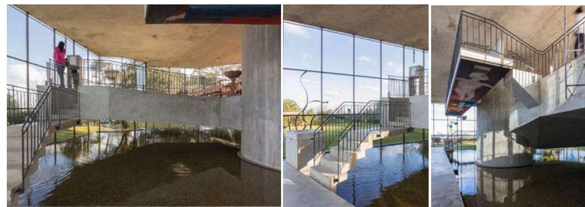
Figuras 54, 55 e 56 – Detalhes da capela.
