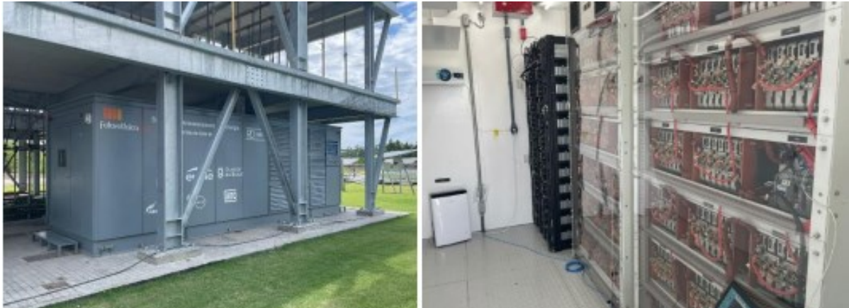
Figura 16 – SAEB do Laboratório FV UFSC.
