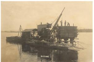
140. Obras para construção do novo porto de Itajaí. Na primeira foto, início da construção do cais em concreto armado e regularização da margem concomitantemente à existência dos trapiches de madeira de casa empres exportadora. 1940, 1943, 1945, respectivamente. Acervo: FGML.
