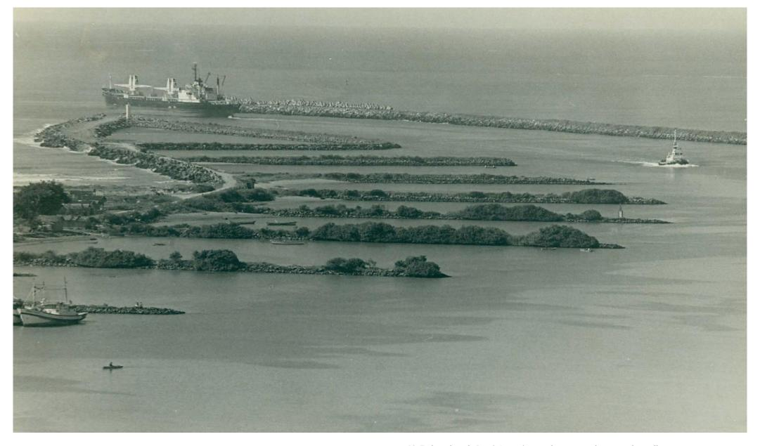
51. Embocadura do Itajaí-Açu após anos da execução do projeto dos molhes e guias-corrente. Vegetação nas enrocamentos, pontos de ancorâgem serguros para barcos de pesca, uma piscina "natural" no Molhe Norte, em Navegantes. Sem data. Fonte: Itajaí de Antigamente. publicação de Abelardo dos Santos.
