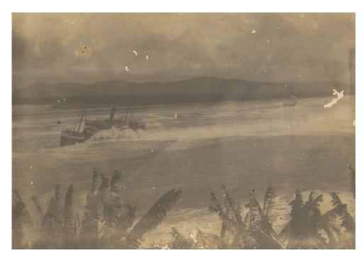
49. Sem as guias-correntes, a depender da profundidade do assoreamento, o risco de entrar no rio era alto. Na foto, Navio Grossherzogin encalhado em um banco de areia na Foz do Itajaí-Açu, década de 1910. Fonte: Itajaí de Antigamente.
