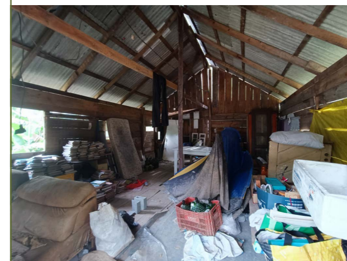
fig. 37. parte interna da casa de apoio fonte: acervo da autora, 2023
