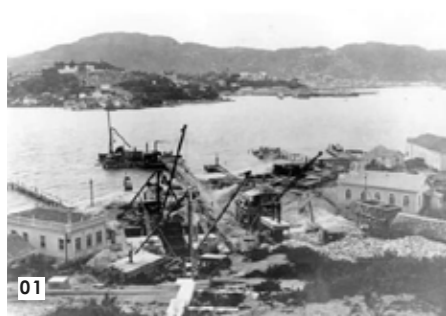
imagem 01: Início da construção da ponte Hercílio Luz 1922 Fonte: Viva a ponte - Linha do tempo
