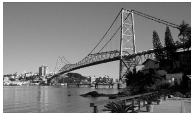
imagem 02: Ponte Hercílio Luz Fonte: Google Maps
