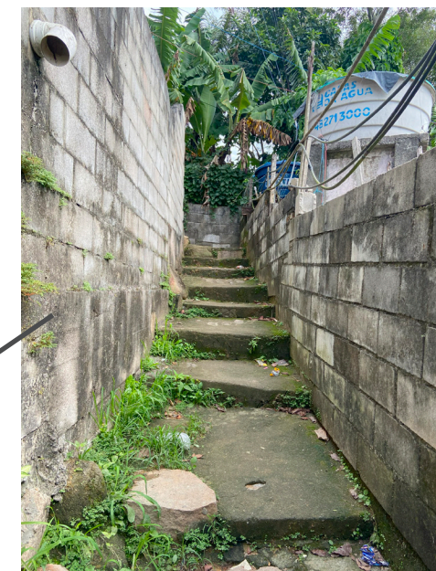
situação atual da escada. registro da autora, 2024.
