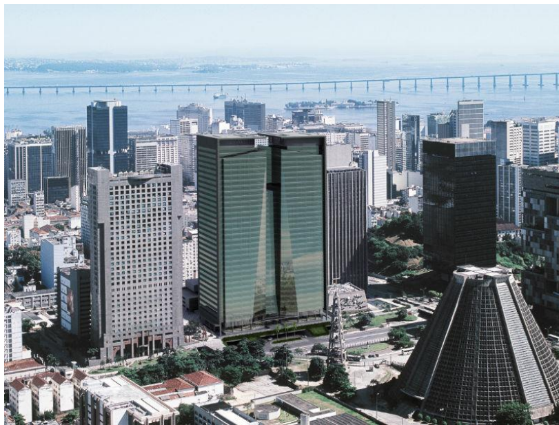
Figura 5: Ao centro o Edifício Ventura (torres espelbadas no centro da imagem), sede do IBM RJ que obteve a certificação Platinum em 2022, Fonte: Prêmio Master Imobiliário
