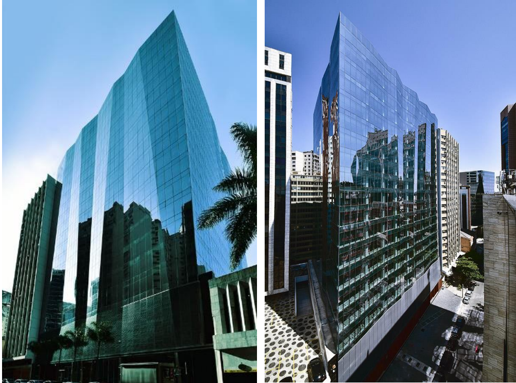
Figura 3: Edifício Vista Mauá no Rio de Janeiro, fachada rua São Bento, Fonte: Vista Mauá (Divulgação)
