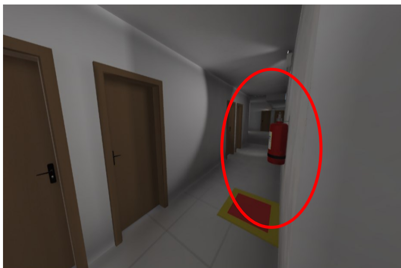
Figura 44 – Extintor no corredor
