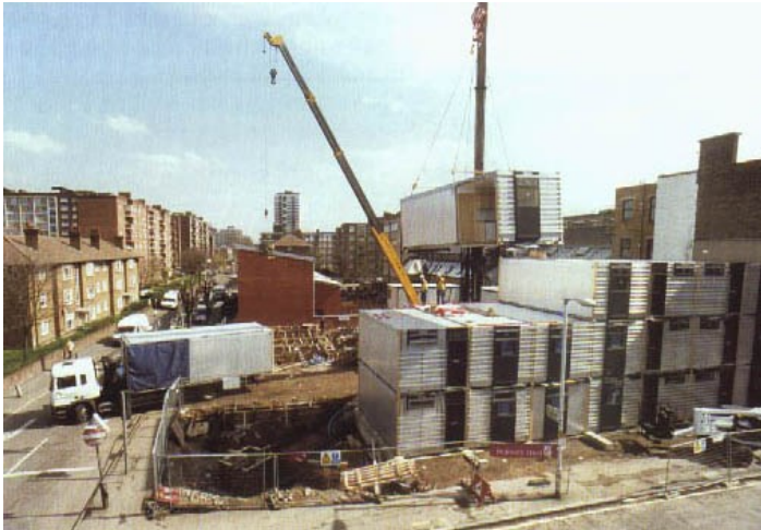
Figura 39 - Unidades modulares formando estrutura autoportante. Instalação de módulo Yorkon.
