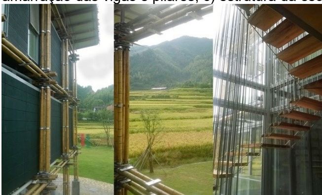
Figura 50 - Vistas dos detalhes construtivos: a) fixação dos painéis na estrutura; b) amarração das vigas e pilares; c) estrutura da escada interna.
