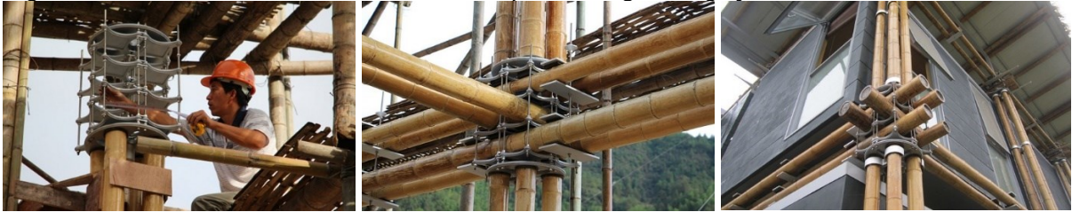
Figura 49 - Detalhe da estrutura de bambu: pilares, vigas e ligações.
