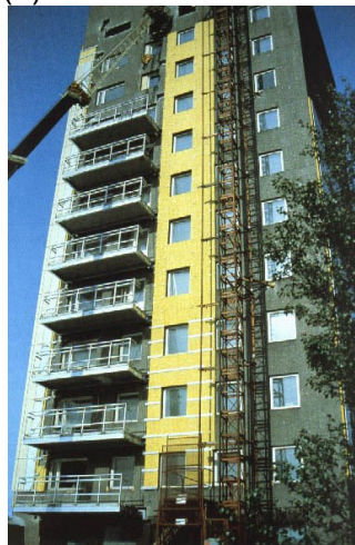
Figura 40 – Unidades modulares apoiadas em estrutura independente: (a) Edifício Hong Kong Shanghai Bank, Hong Kong. (b) Acréscimo de varandas e painéis verticais em fachada.
