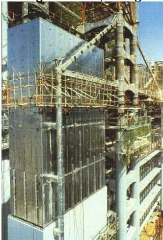
Figura 40 – Unidades modulares apoiadas em estrutura independente: (a) Edifício Hong Kong Shanghai Bank, Hong Kong. (b) Acréscimo de varandas e painéis verticais em fachada.
