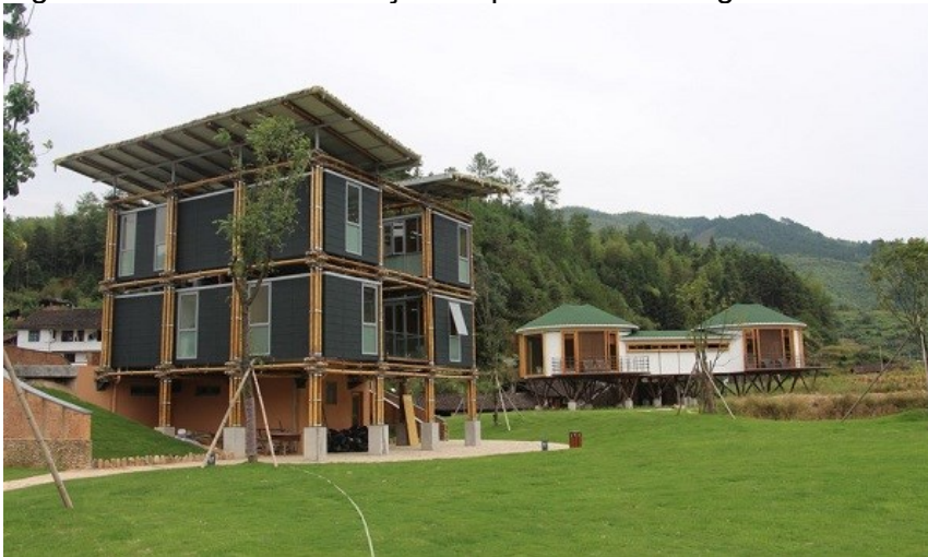
Figura 46 - Vista da edificação no panorama da região.
