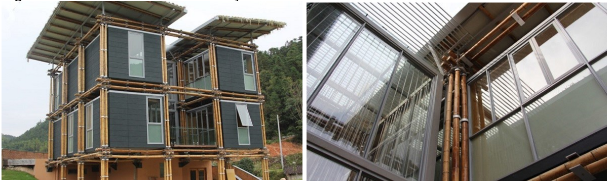
Figura 47 - Vista externa da edificação.
