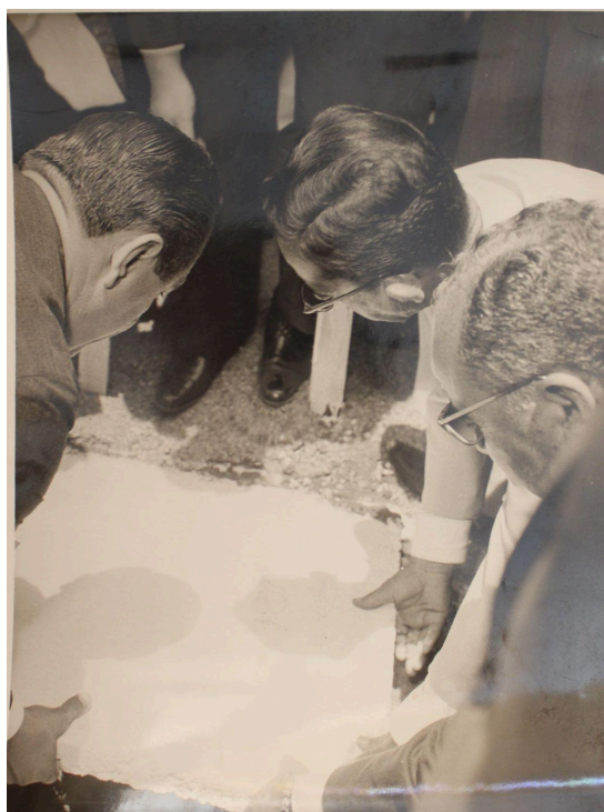
Figura 8 - Momento em que é colocada a pedra fundamental da Mesquita de Barretos, no ano de 1962.
