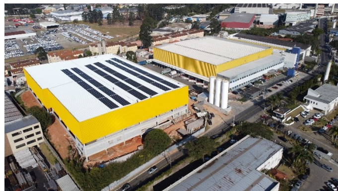
Figura 27 - Conjunto de módulos do Sistema FV 7
