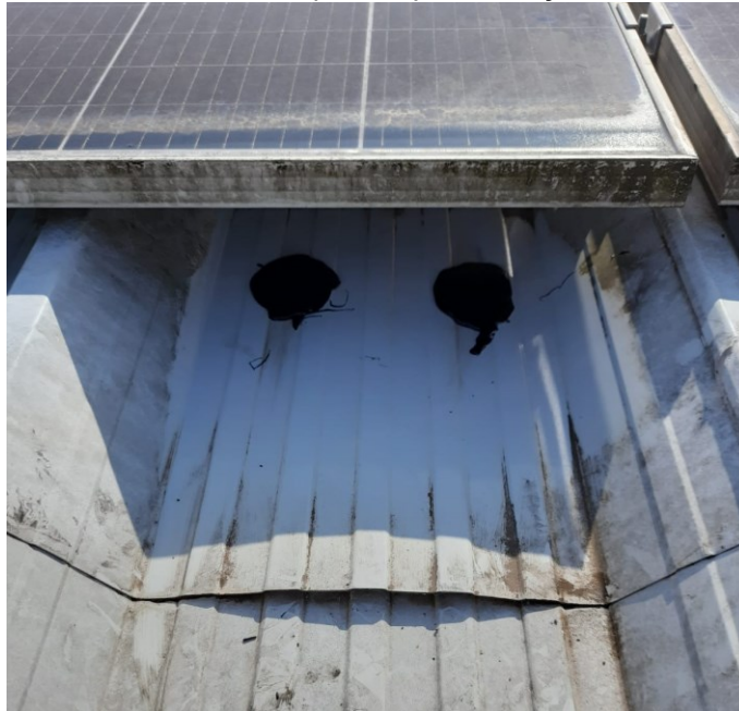
Figura 28 - Foto do serviço de vedação do telhado com detalhe para o módulo sujo e o selante asfáltico aplicado para vedação
