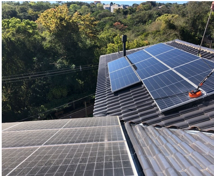
Figura 14 - Limpeza dos módulos do Sistema FV 2
