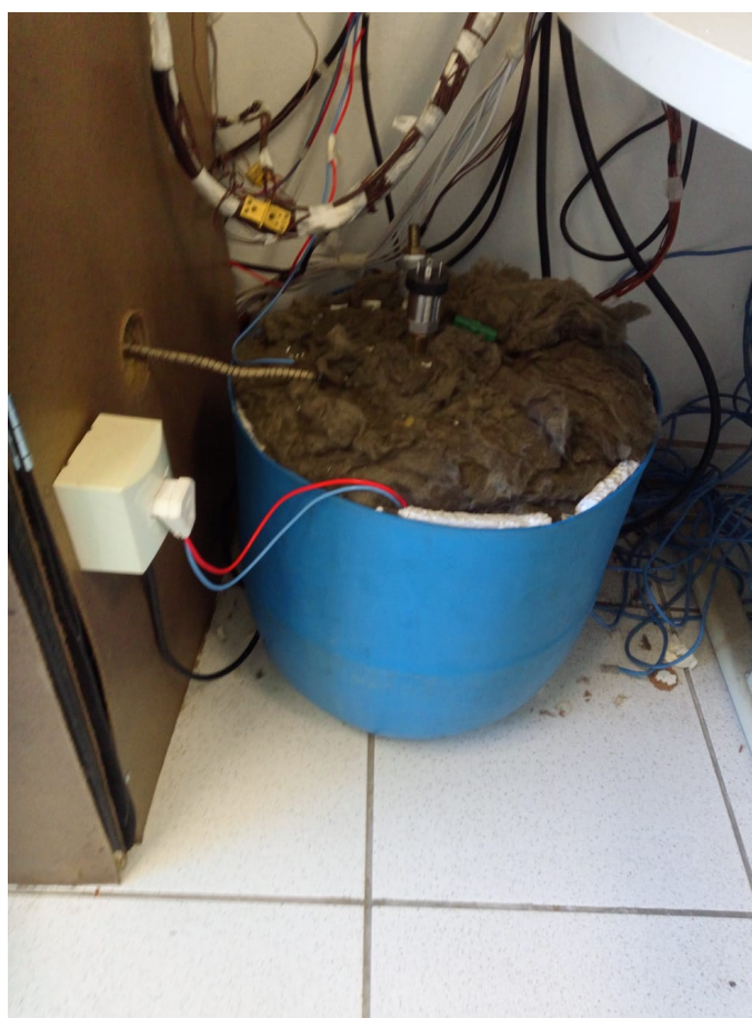
Figura 7 – Sistema de umidificação
