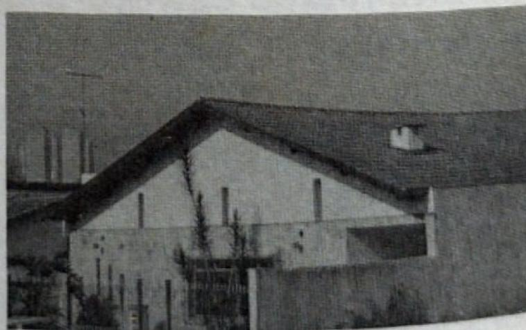
Observe alguns telhados. Note que existem vários tipos de telha. A telha francesa, por exemplo, exige uma inclinação de pelo menos 40%, para que a água das chuvas possa escoar-se.
