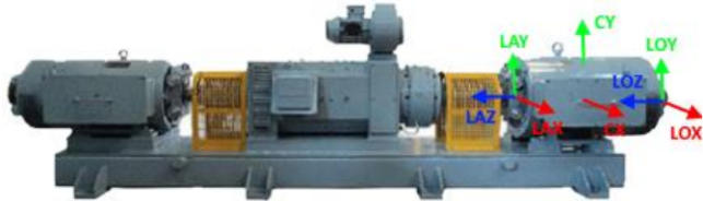
Fig. 1. Bancada de testes para imposição de faltas com posições dos acelerômetros instalados indicadas.
