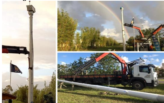
Figura 32 – Torre de concreto utilizada
