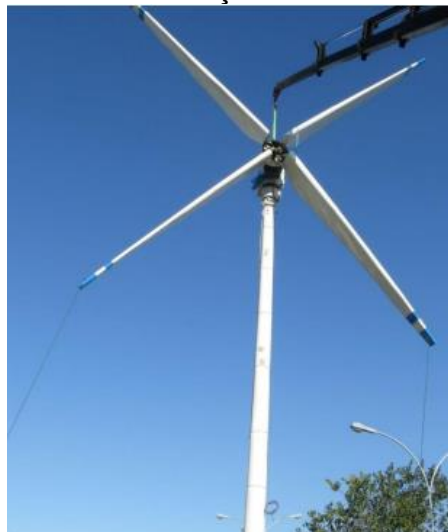
Figura 50 – Instalação da turbina eólica
