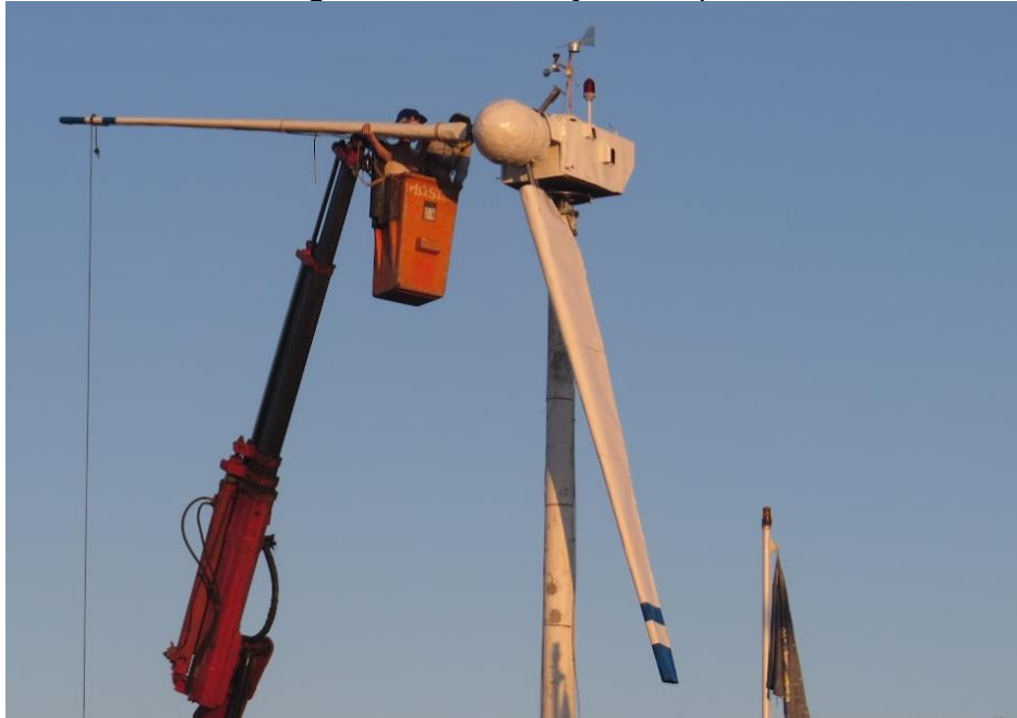
Figura 58 – Instalação das pás
