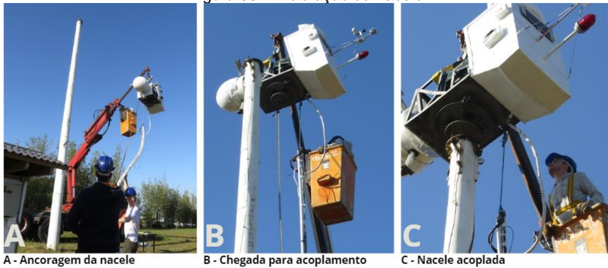
Figura 56 – Instalação da nacele
