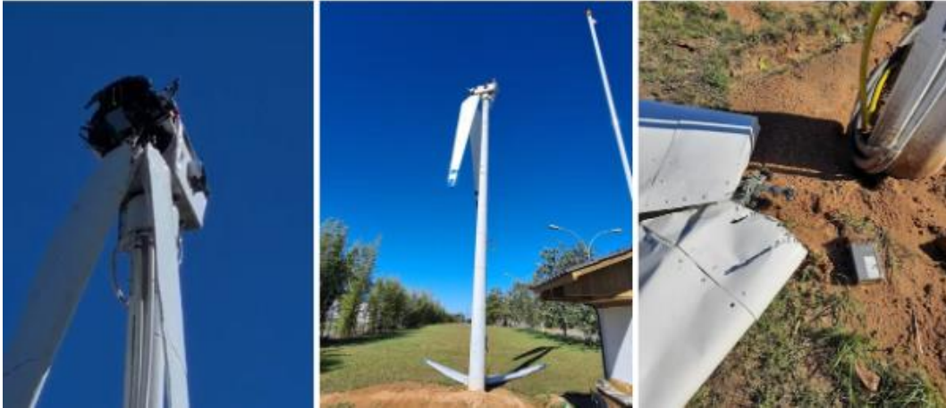
Figura 52 – Danos estruturais na primeira versão do projeto
