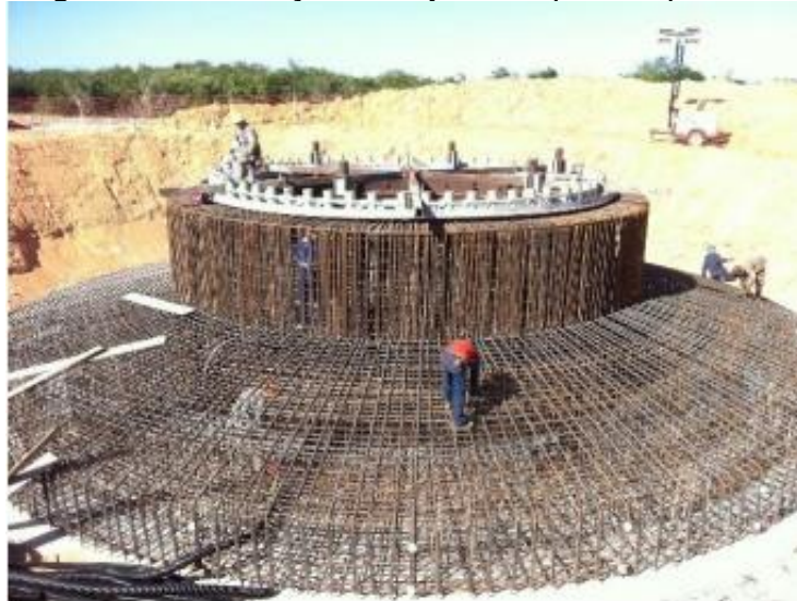
Figura 9 – Fundação de laje de sapata superficial
