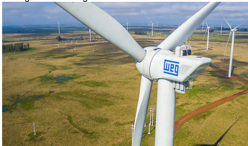
Figura 6 – Aerogerador comercial de eixo horizontal
