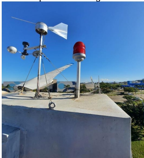
Figura 44 – Estação meteorológica do aerogerador
