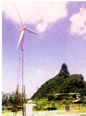
A - primeiro aerogerador
