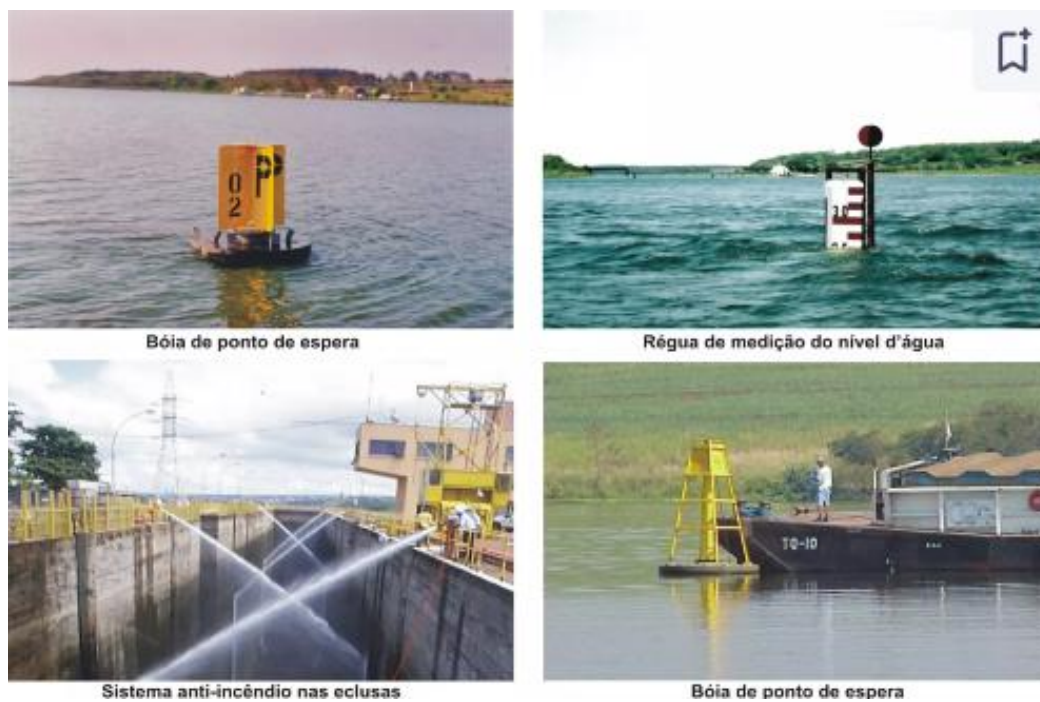
Figura 9 - Sistema de combate a incêndio e sinais especiais de navegação.
