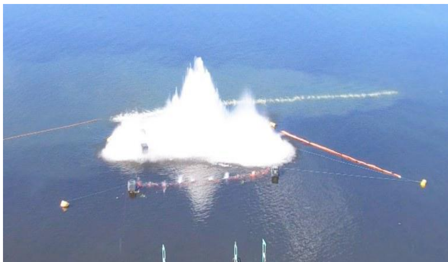
Figura 6 - Detonação de Pedra Submersa em Nova Avanhandava.
