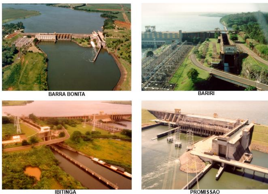
Figura 1 – Eclusas da Hidrovia Tietê (SP).
