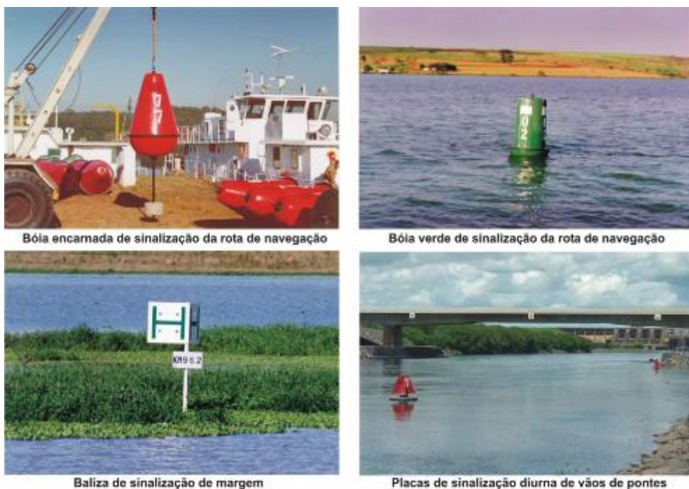
Figura 8 – Boias e Placas delimitadoras de canal preferencial de navegação.
