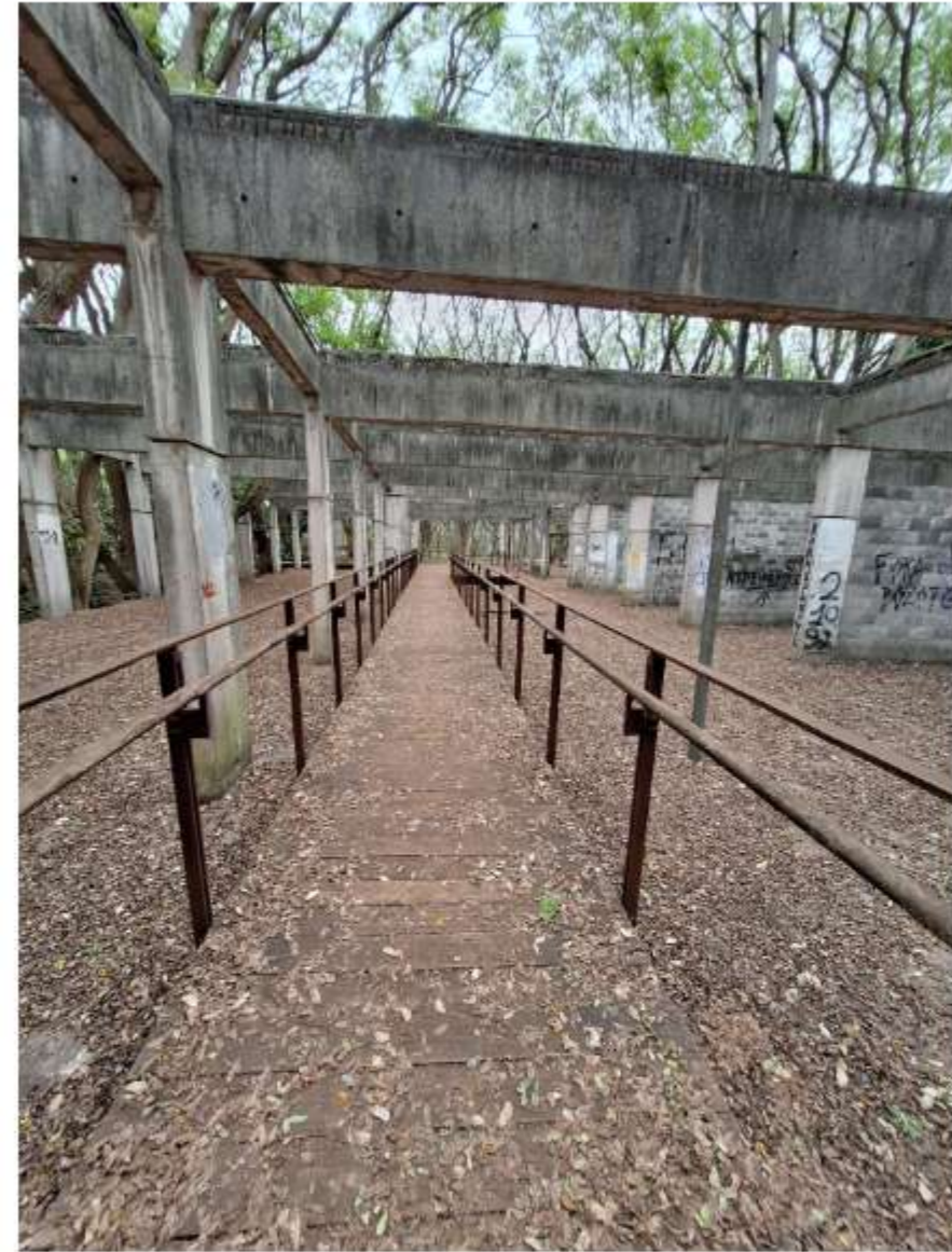
Ruínas e partes da estrutura do antigo Pavilhão 9 do complexo do Carandiru - Foto: Pedro Ordones
