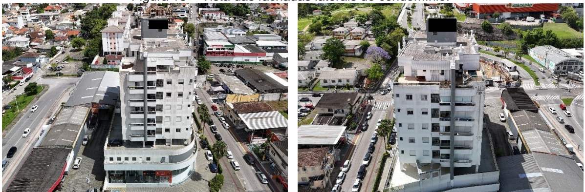
Figura 18 – Vista das fachadas laterais do condomínio.
