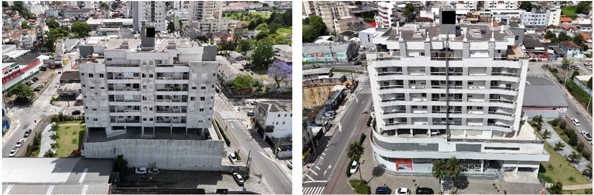
Figura 17 – Vista da fachada frontal e dos fundos do condomínio.
