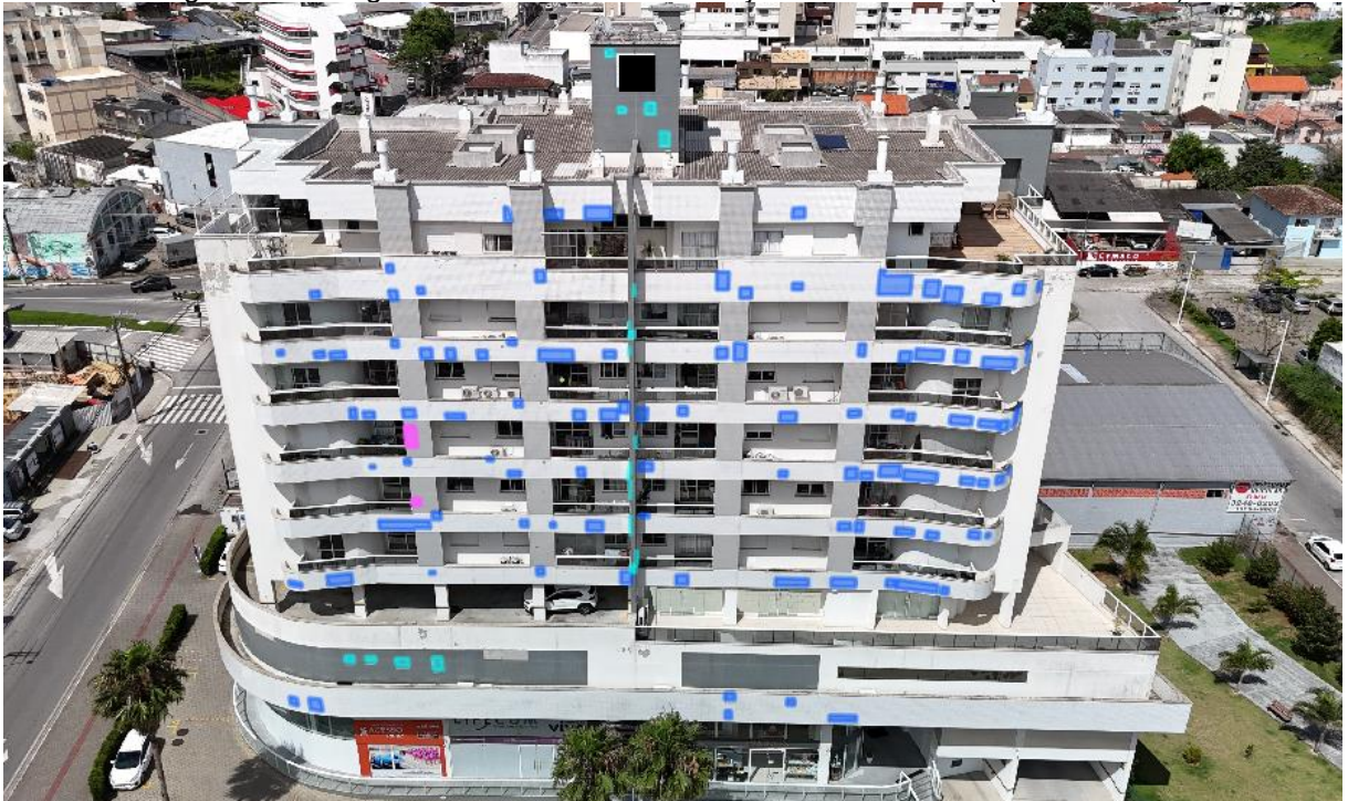
Figura 45 – Imagem de drone com as marcações de som cavo (fachada norte)
