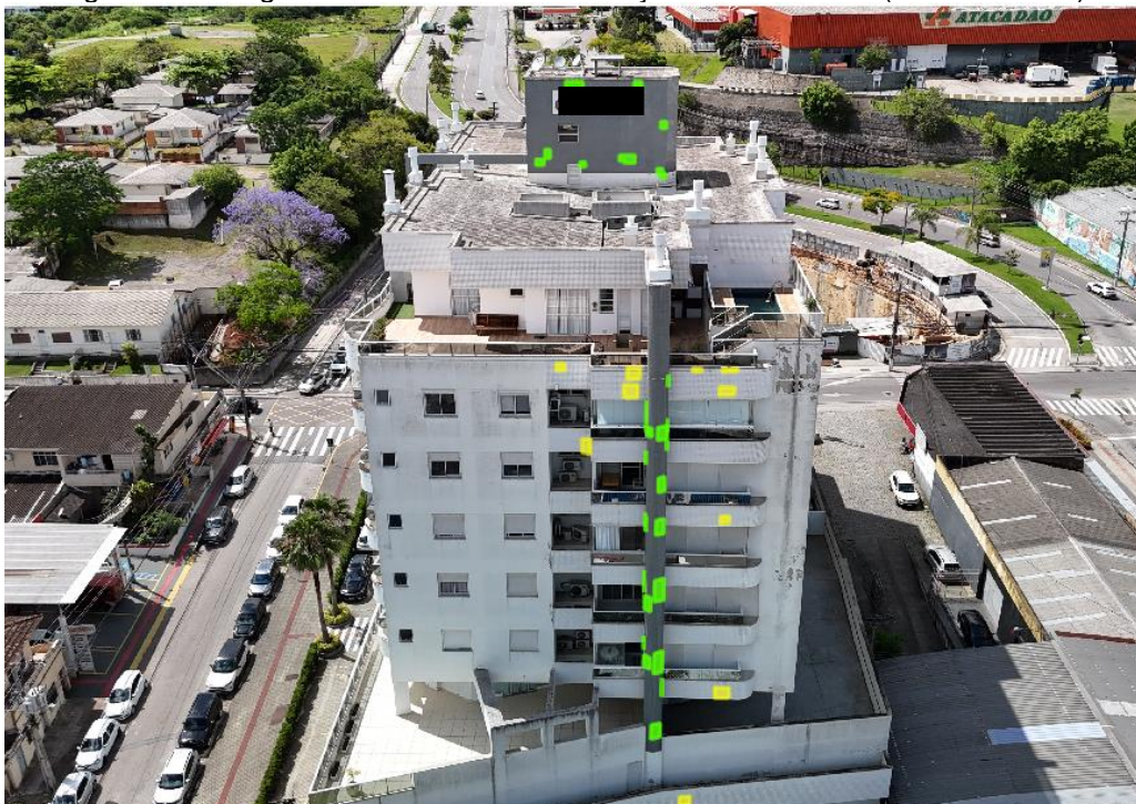
Figura 49 - Imagem de drone com as marcações de som cavo (fachada oeste)
