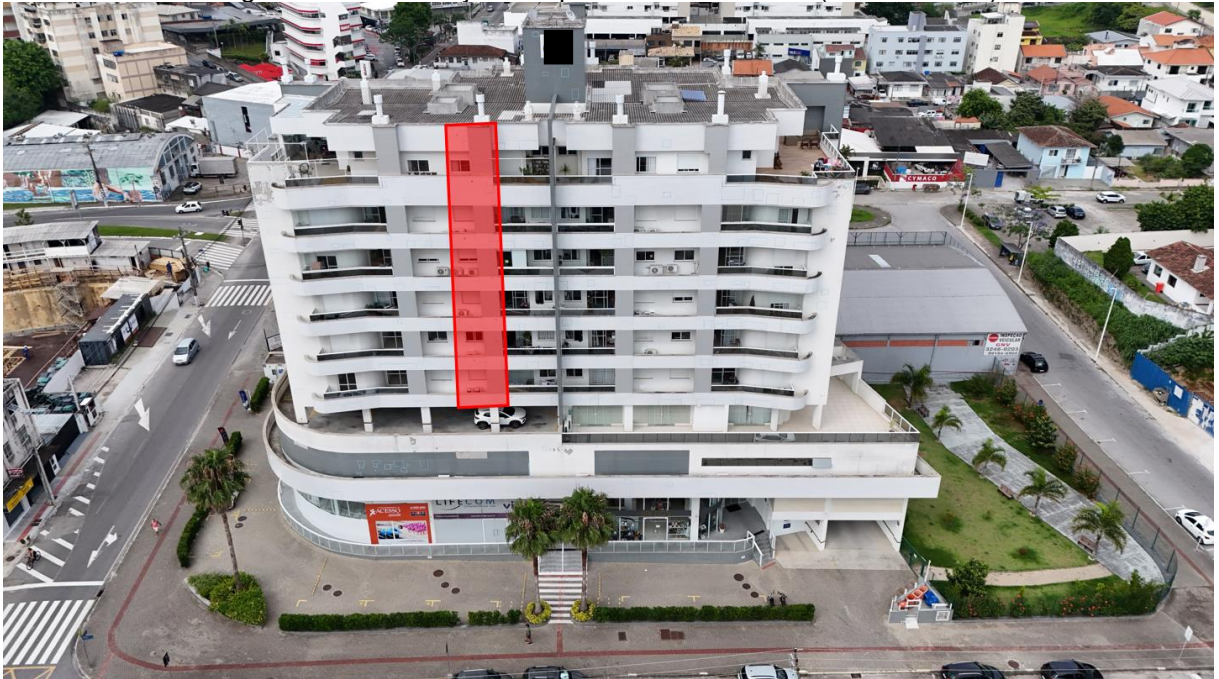
Figura 34 – Localização dos pontos arrancamento (fachada norte)
