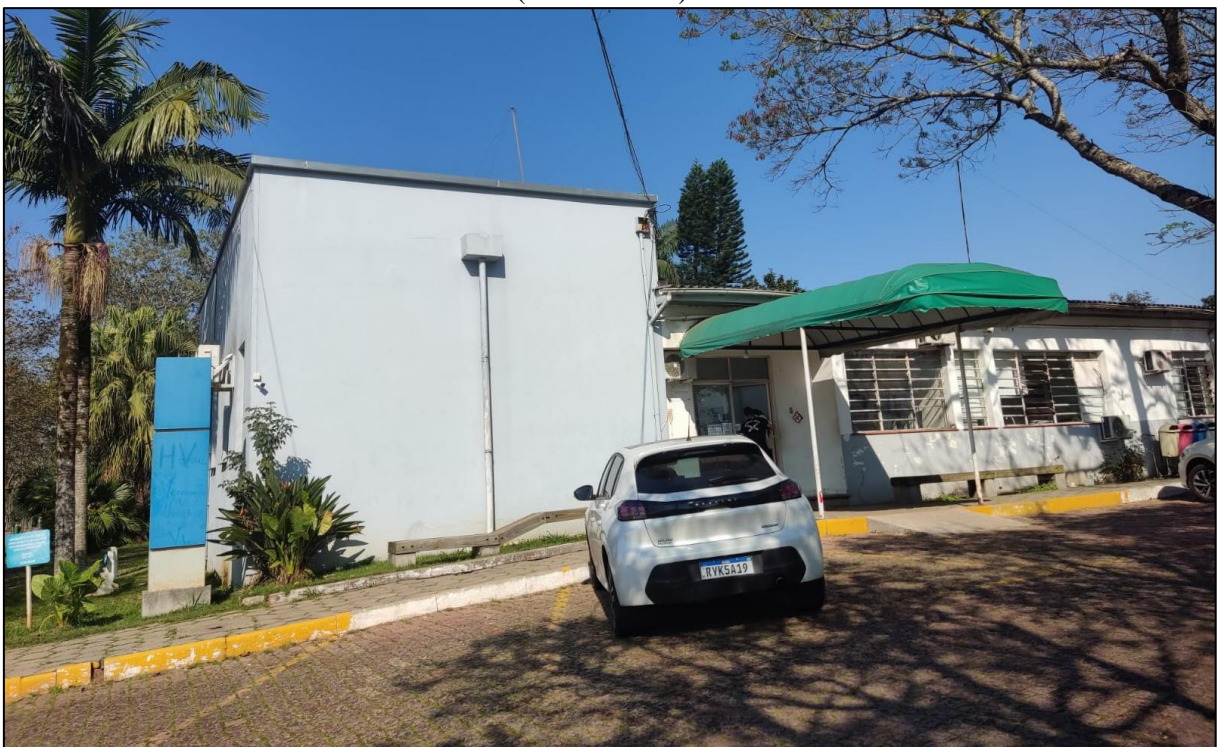
Figura 1 – Fachada do Hospital Veterinário Universitário da Universidade Federal de Santa Maria (HVU-UFSM).
