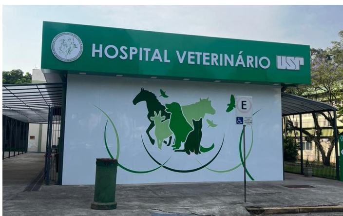
Figura 11. Fachada do Hospital Veterinário da FMVZ – USP.
