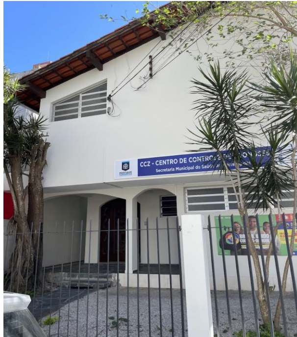
Figura 1. Fachada do Centro de Controle de Zoonoses (CCZ)
