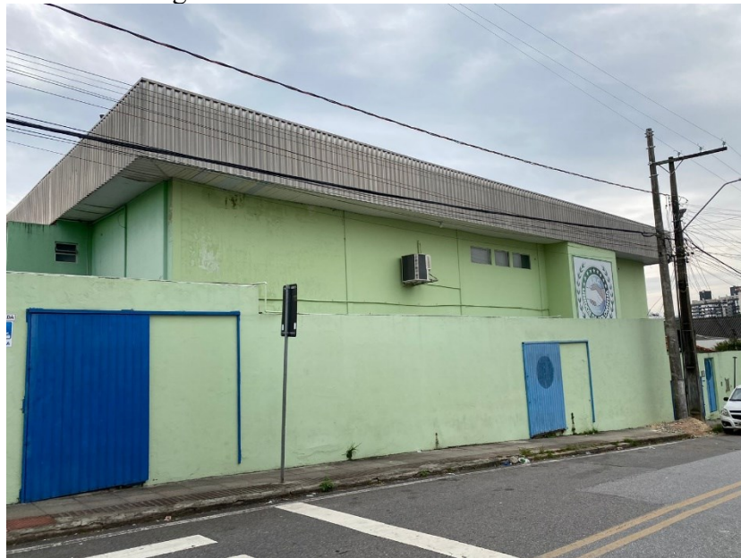
Figura 3 – Fachada da Escola de Samba
