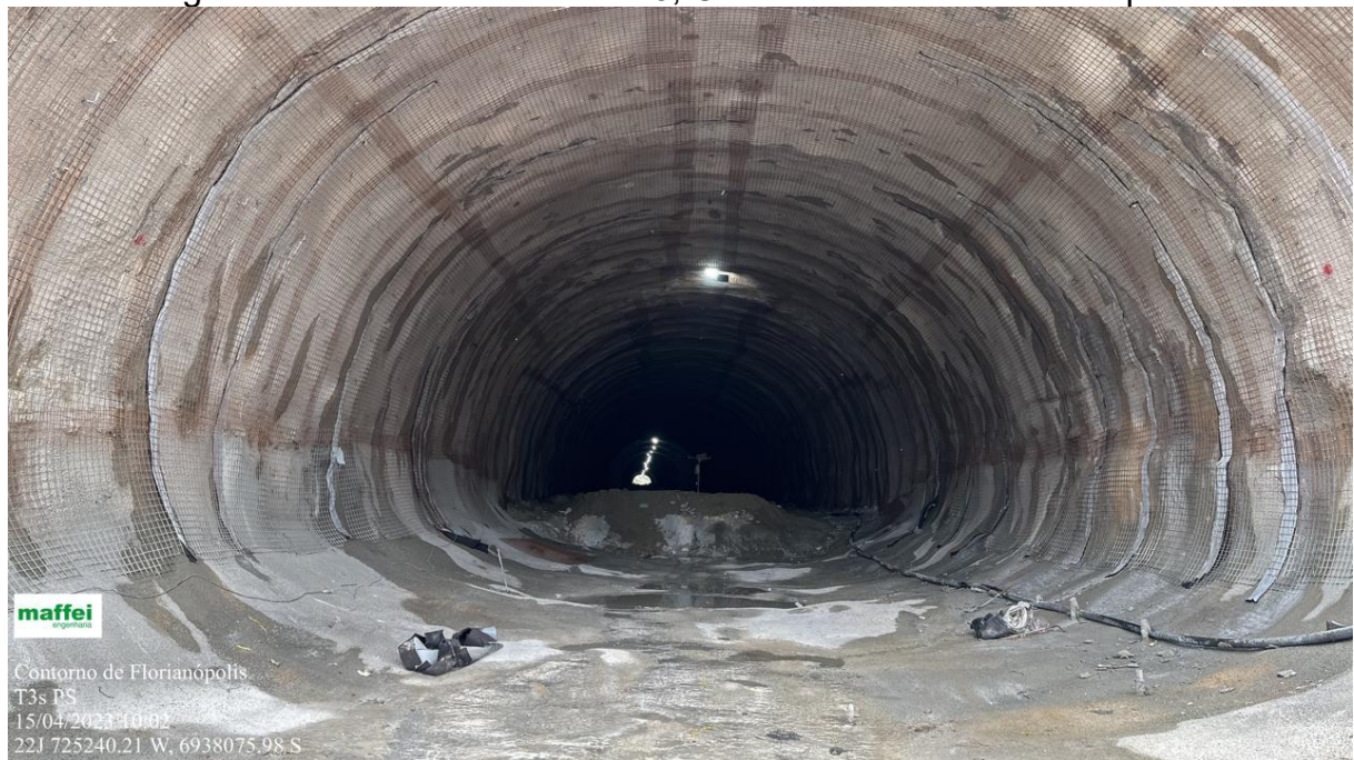
Figura 7 – Arco Invertido Túnel 3, Contorno Viário de Florianópolis.
