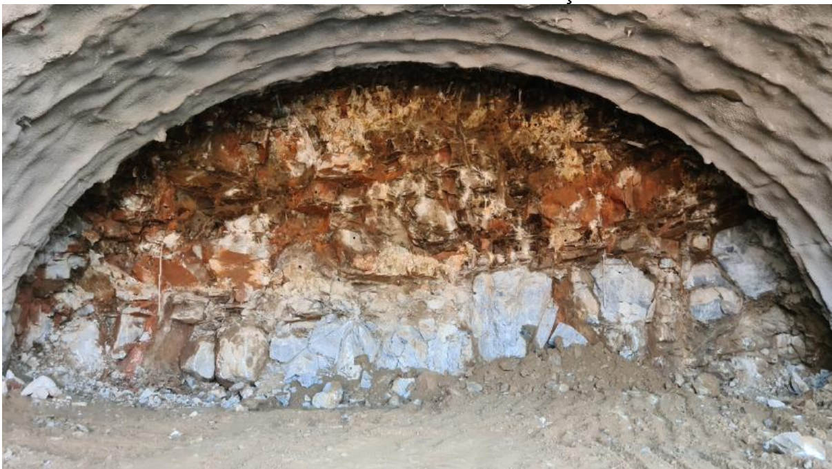
Figura 52 – Escavação do emboque sul, pista norte, em seção mista com transição de rocha pouco alterada a sã na base da escavação para rocha alterada dura a rocha alterada mole no teto da seção.
