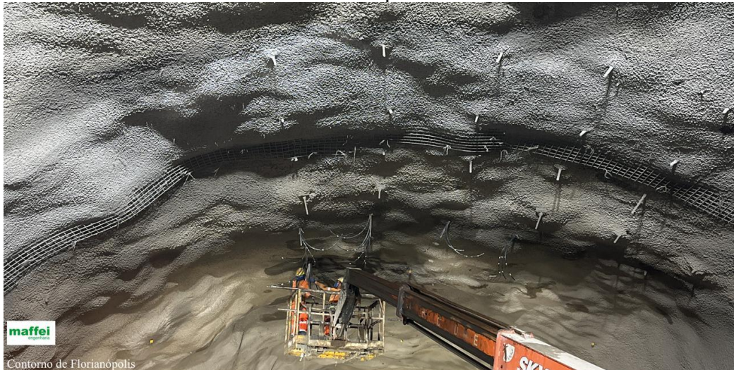
Figura 10 – Instalação de malha de tirantes, Túnel 2, Contorno Viário de Florianópolis.
