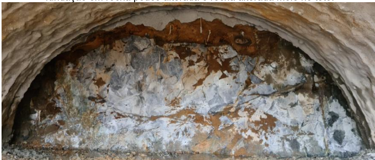
Figura 54 – Frente de escavação emboque norte, pista norte, em seção mista com fundação em rocha pouco alterada e rocha alterada mole no teto.
