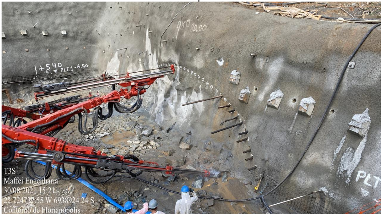
Figura 3 – Perfuração de enfilagem no emboque do Túnel 3, Contorno Viário de Florianópolis.
