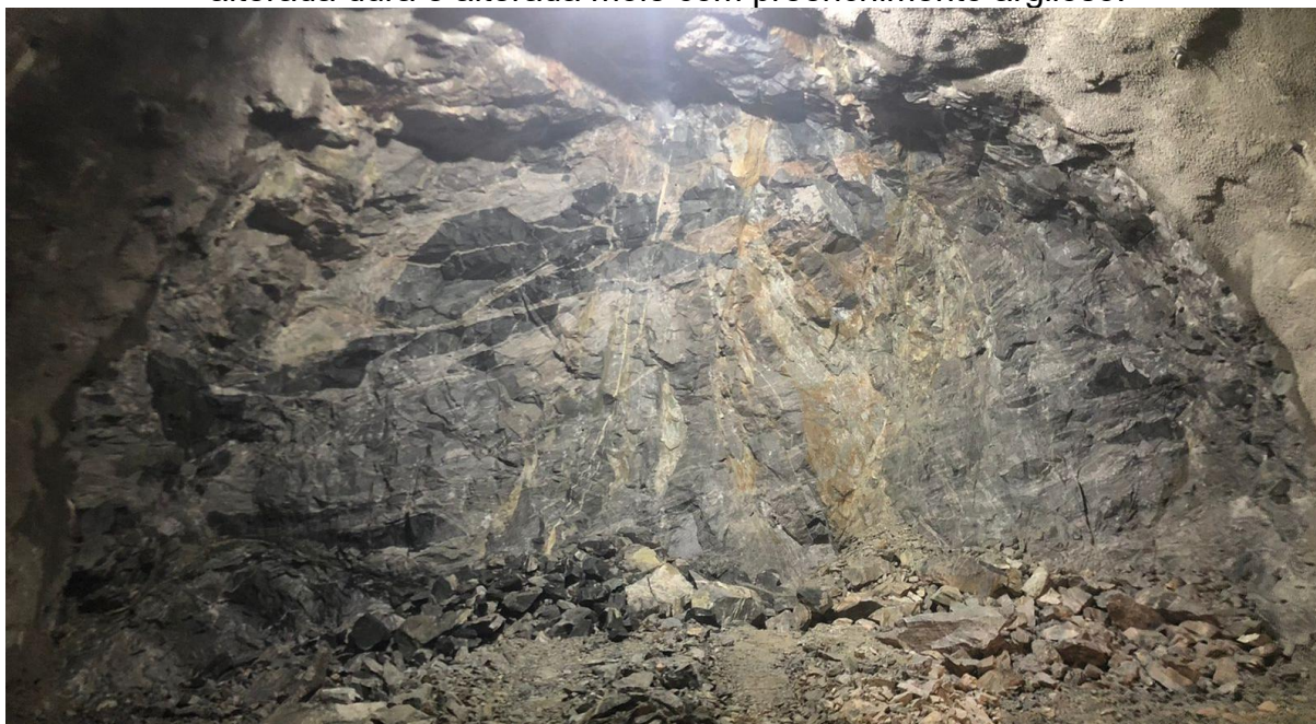
Figura 56 – Frente de escavação estaca aproximada 226+012, pista sul, com presença de zona de cisalhamento subvertical, N311/66, com intercalação de rocha alterada dura e alterada mole com preenchimento argiloso.
