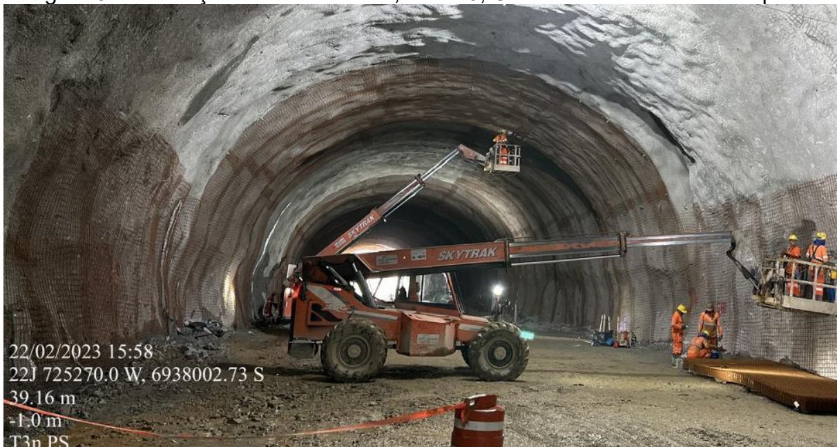
Figura 9 – Instalação de tela metálica, Túnel 3, Contorno Viário de Florianópolis.
