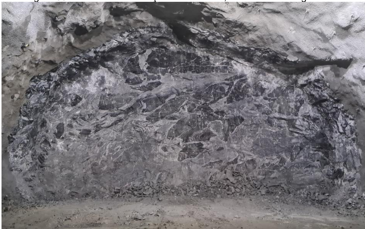
Figura 55 – Frente de escavação em rocha sã, com estrutura migmatítica.
