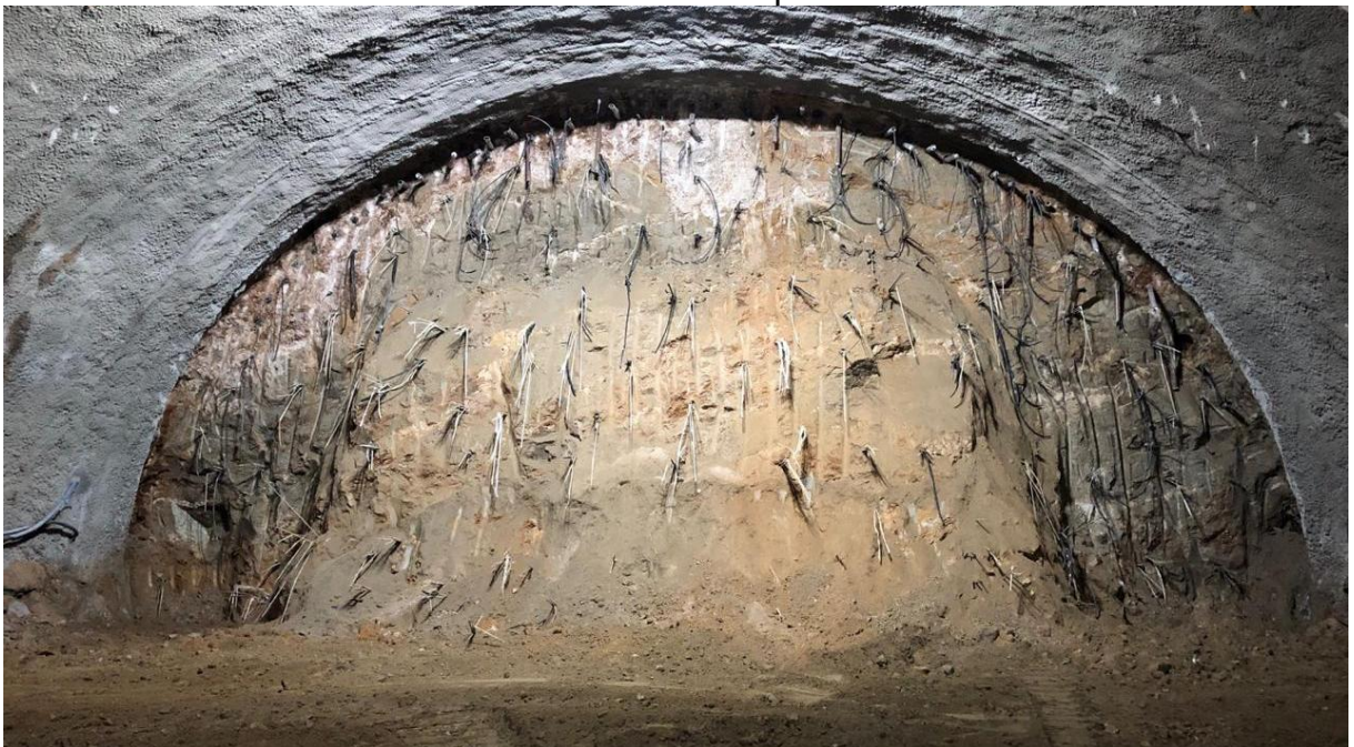
Figura 5 – Pregagem de fibra de vidro na face da escavação do Túnel 2, Contorno Viário de Florianópolis.
