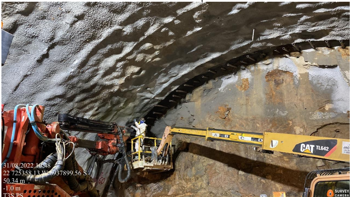
Figura 4 – Perfuração de enfilagens no contorno da escavação, Túnel 3, Contorno Viário de Florianópolis.
