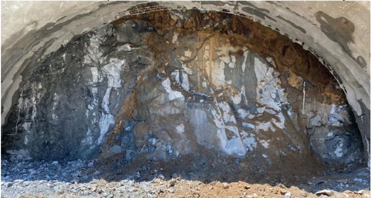
Figura 53 – Escavação do emboque norte, pista sul. Presença de fundação em rocha alterada dura a pouco alterada com rocha alterada mole no teto da seção.
