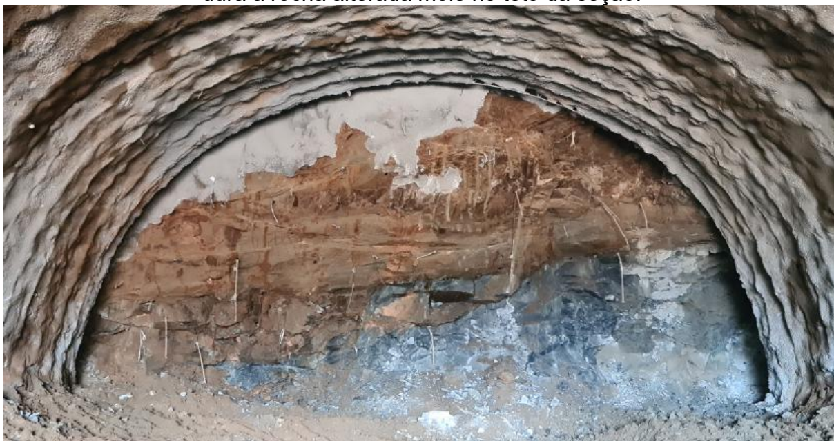
Figura 50 – Escavação em seção mista na pista sul, emboque sul. Presença de rocha pouco alterada a sã na base da escavação, graduando para rocha alterada dura a rocha alterada mole no teto da seção.
