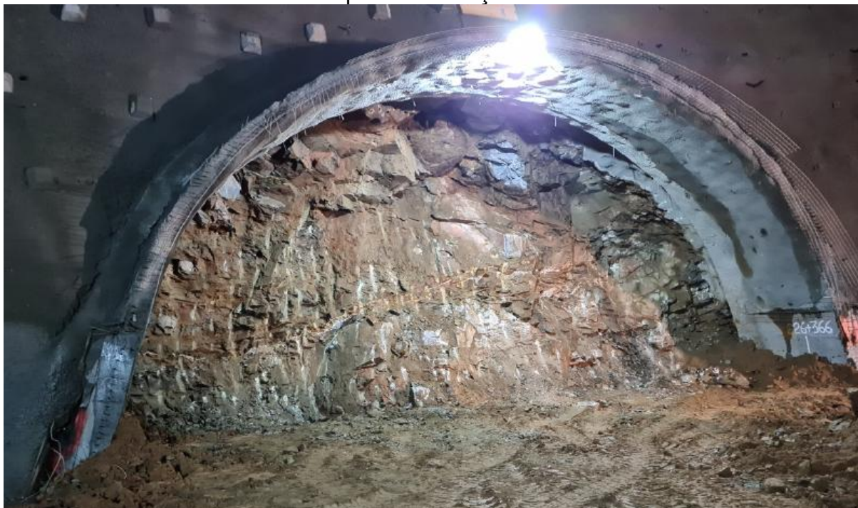
Figura 51 – Escavação na região do emboque sul, pista norte em seção mista com presença de rocha alterada mole intercalada com blocos de rocha alterada dura a sã por toda a seção.
