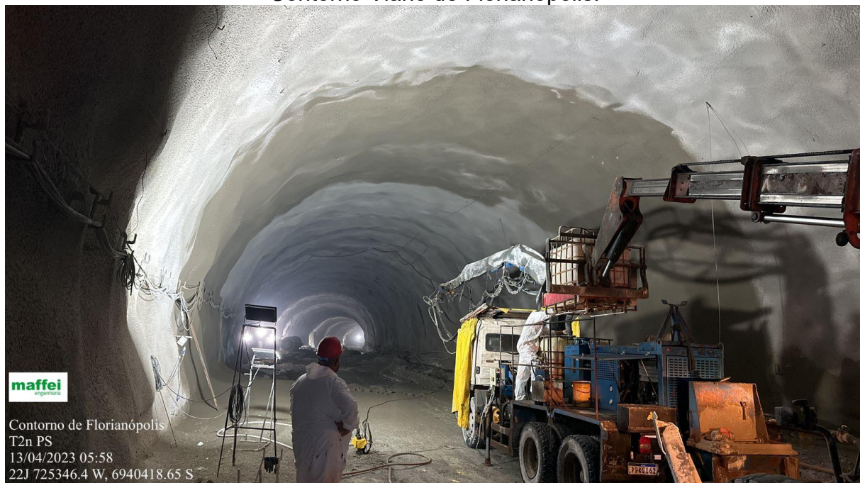
Figura 1 – Aplicação de concreto projetado para regularização de forma no Túnel 2, Contorno Viário de Florianópolis.
