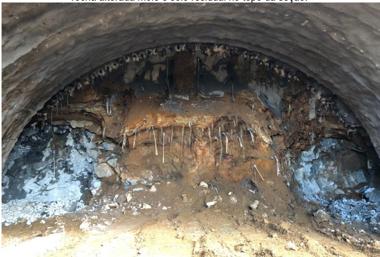
Figura 49 – Escavação da pista norte, emboque norte, em seção mista, com presença de rocha pouco alterada a sã na base da escavação, graduando para rocha alterada mole e solo residual no topo da seção.
