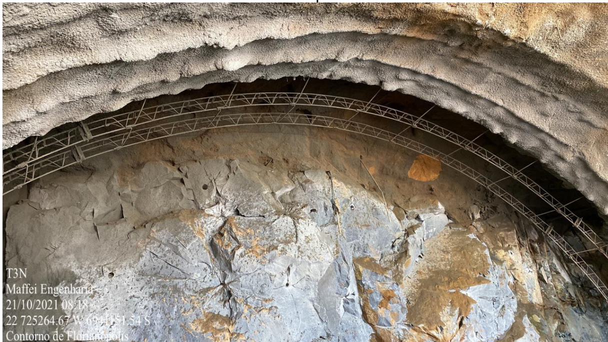
Figura 6 – Escavação em solo, utilização de cambota, Túnel 3, Contorno Viário de Florianópolis.
