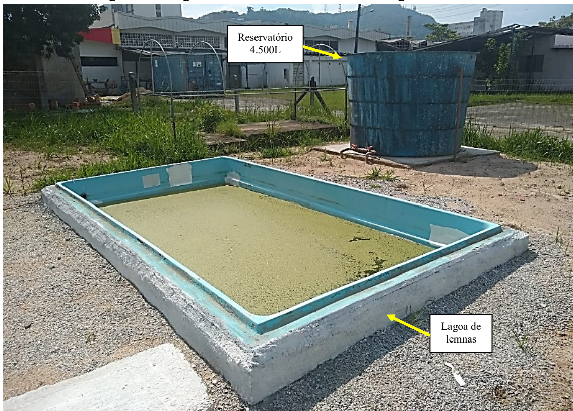
Figura 6 – Lagoa de lemnas e reservatório de água de reuso.
