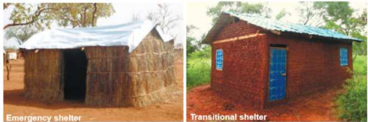
Figura 18 - Estrutura de Abrigos Emergenciais/Temporários no ATP-01
