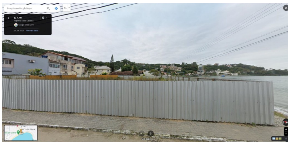
Figura 24 — Edificação no Bairro Canto da Praia em junho 2024.
