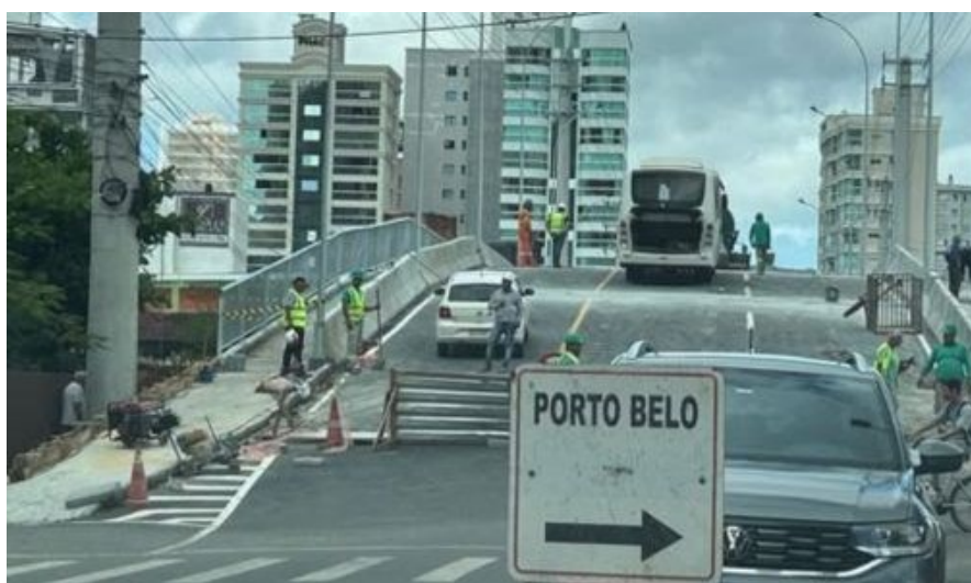
Figura 51 — Ponte sobre o Rio Perequê.
