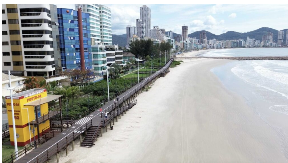
Figura 53 — Passarela de ligação entre a Meia Praia e Centro.
