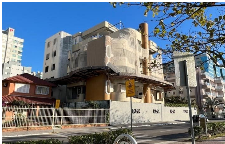
Figura 19 — Edificação em demolição na Av. Beira-Mar em agosto de 2024.
