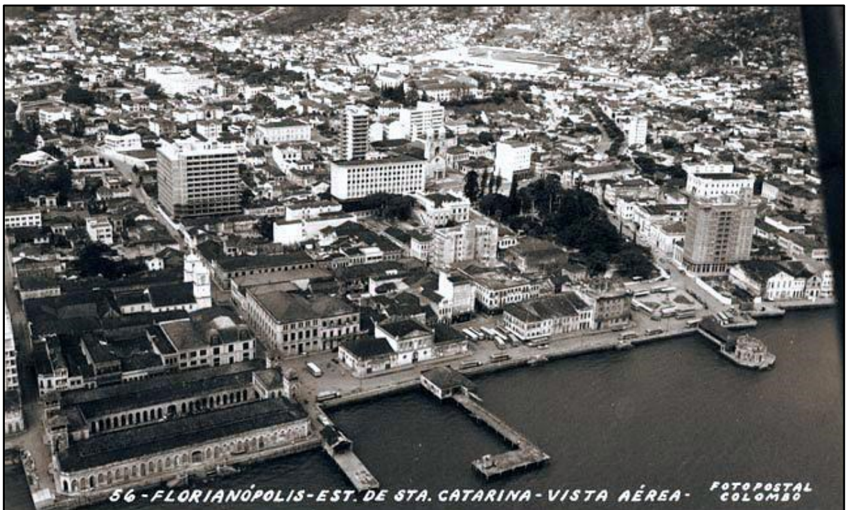
Figura 14 - Vista aérea da área do Mercado (1956)
