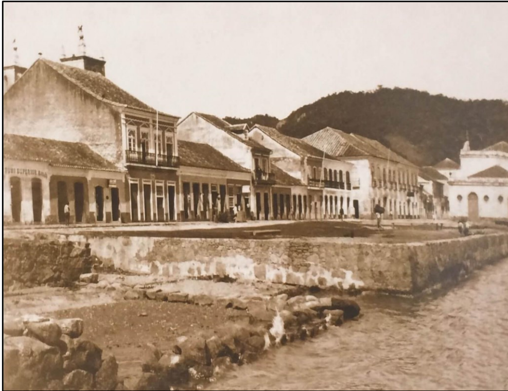
Figura 6 - Aterro para a construção do Mercado Novo (1896)
