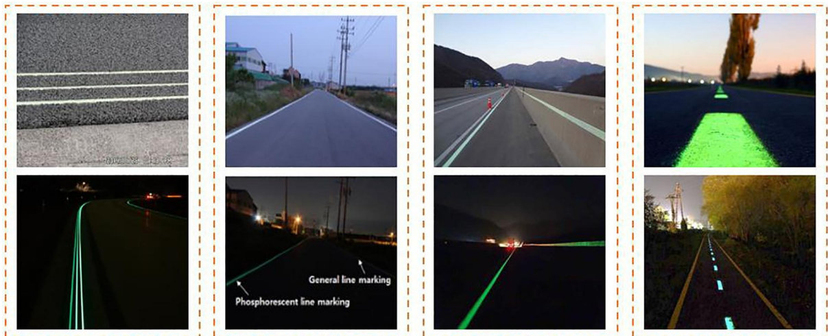
Figura 7– Auto-estradas iluminadas com materiais fosforescentes.
