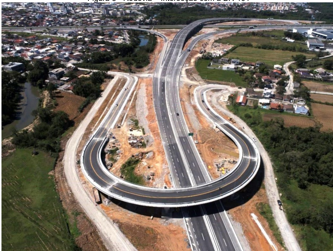
Figura 3 - Rodovia – Interseção com a BR-101
