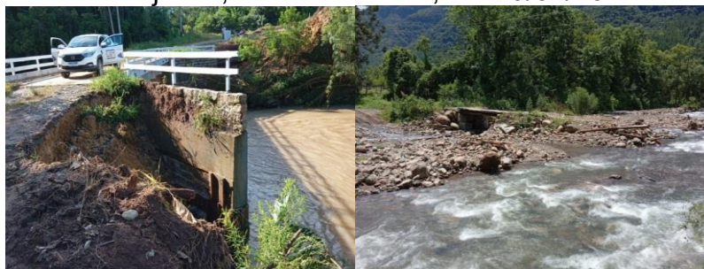
Figura 41 – Cabeceira da ponte do Rio Laranjeiras na Ponte Preta e margem do Rio Laranjeiras, em Três Barras, em 29/01/2024
