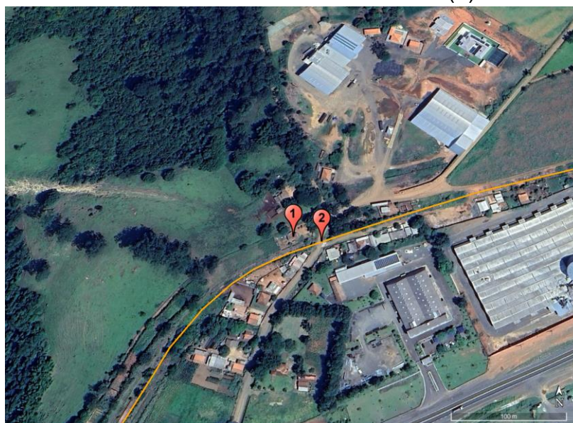
Figura 6 – Vista superior do local onde existia a escola (1) e da interseção entre a linha férrea e a rua José da Cruz (2)
